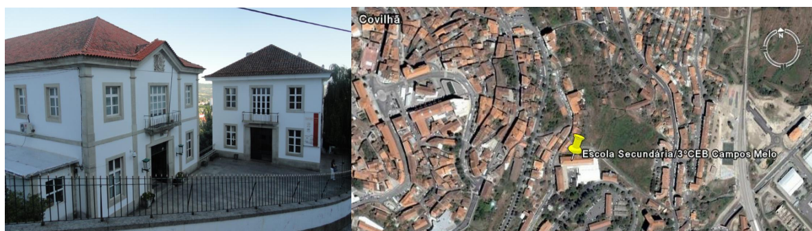
Figura 58 - Fachada da Escola Secundária de Campos Melo e sua localização (in Google)
