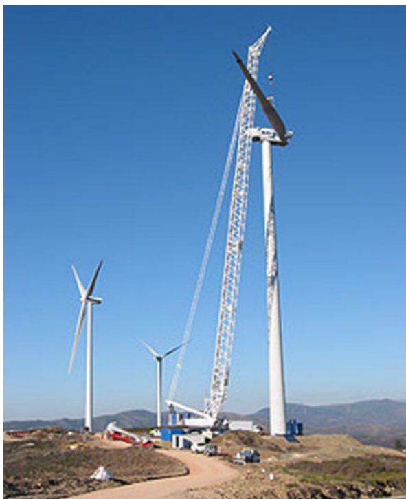
Figura 6.1 – Montagem de um aerogerador, num parque eólico [I12]
