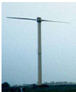
Figura 5.21: Turbina eólica com rotor de duas pás [53]
