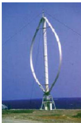
Figura 5.5: Turbina eólica com rotor Darrieus [I6]
