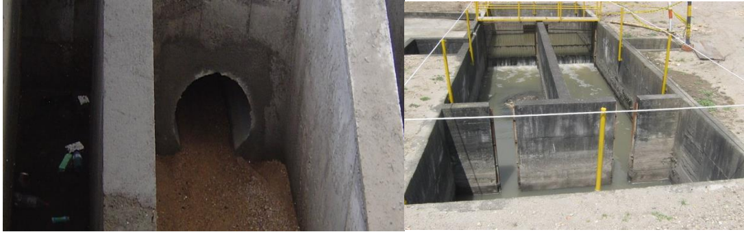
Figura 2.5 - Desarenador para remoção de areias
