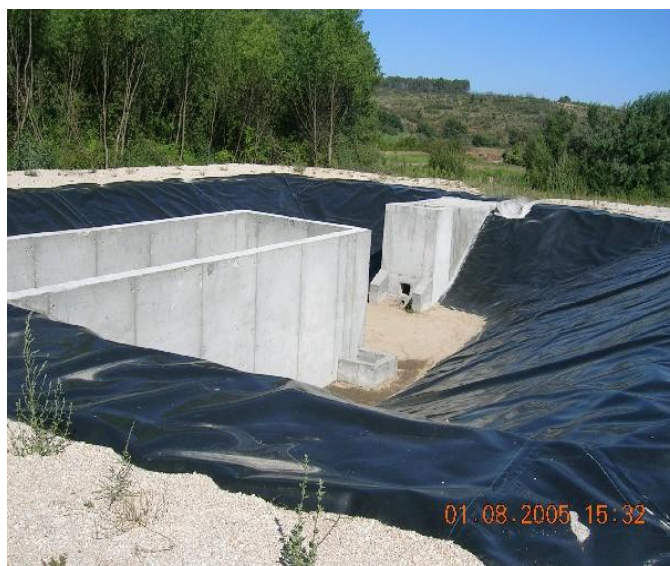
Figura 2.9 - Bacia de detenção para AEE
