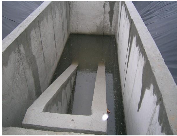
Figura 2.6 - Desengordurador para remoção de óleos e gorduras
