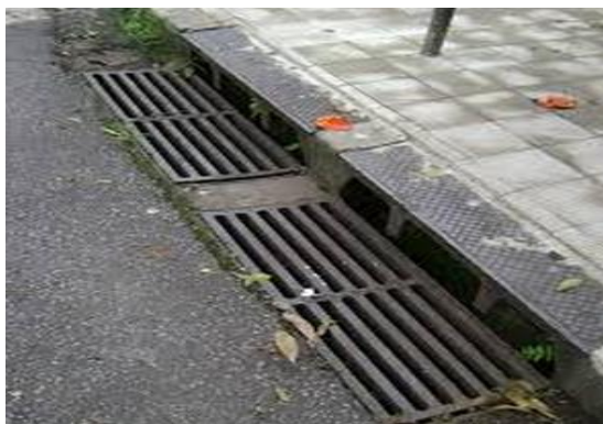
Figura 2.3 - Sumidouros para recolha de águas pluviais
