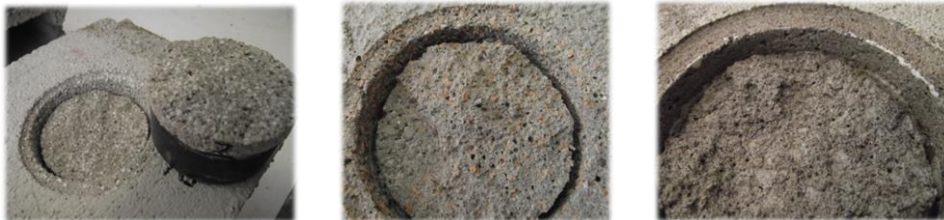
Figura 5.32. Rotura pela argamassa em argamassas com EPS, COR, CEX
