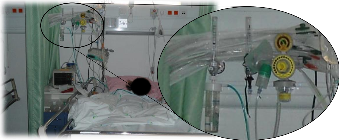
Figura 14 - Pormenor da disposição das sondas de aspiração, empilhadas atrás dos debitómetros
