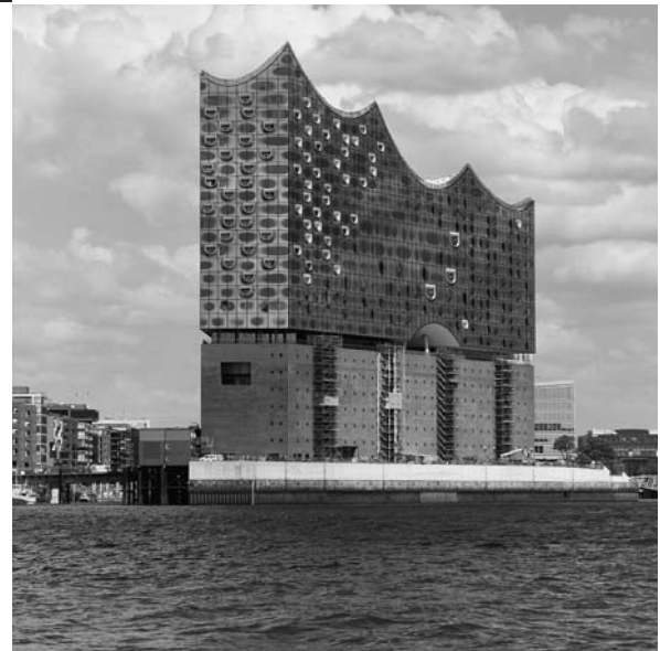
Elbe Philharmonic Hall | Herzog & de Meuron | 03.11.2015
