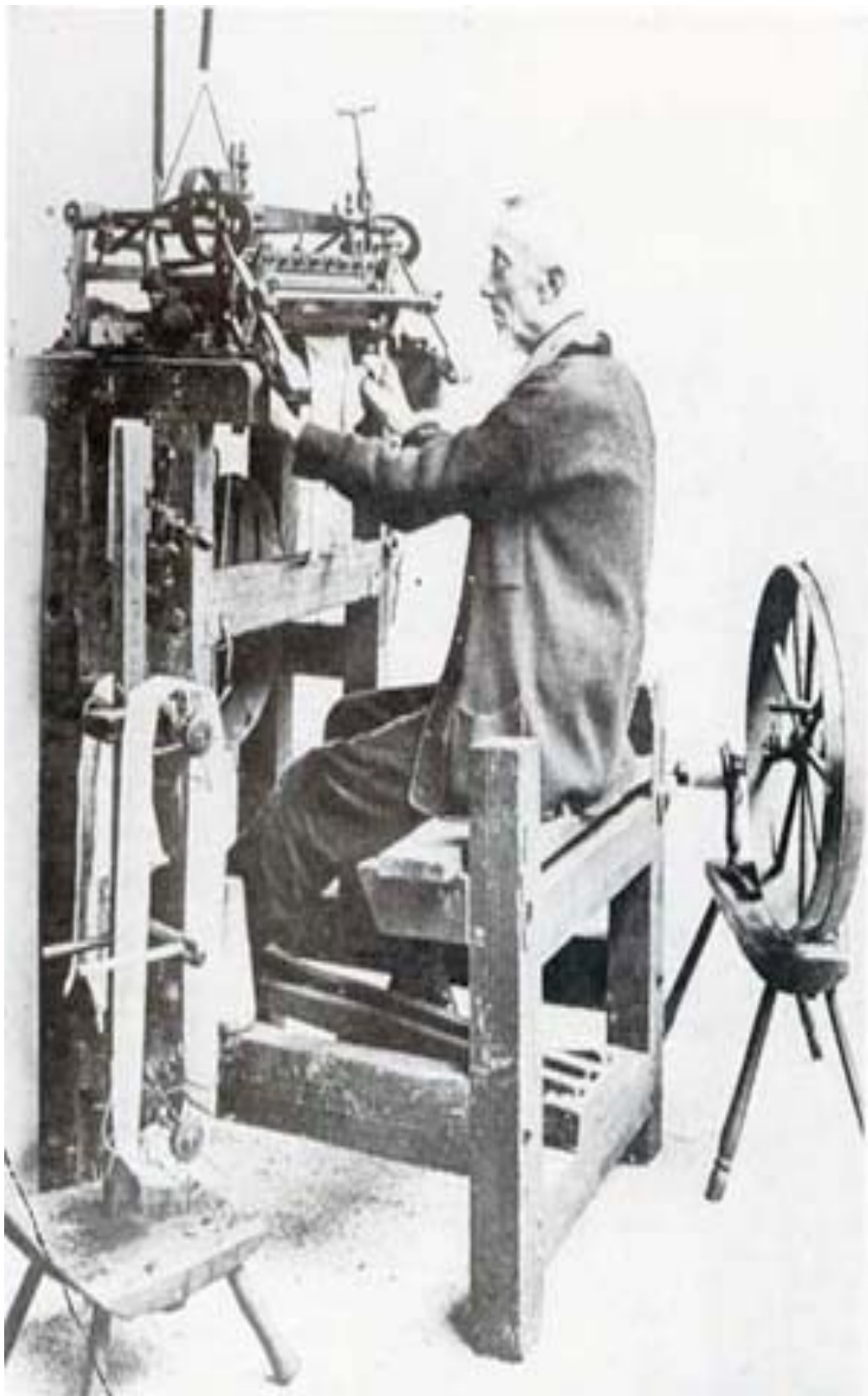
Figura 5. Primeira máquina de tricô, criada por William Lee em 1589 (Fonte: larkabout.wordpress.com)
