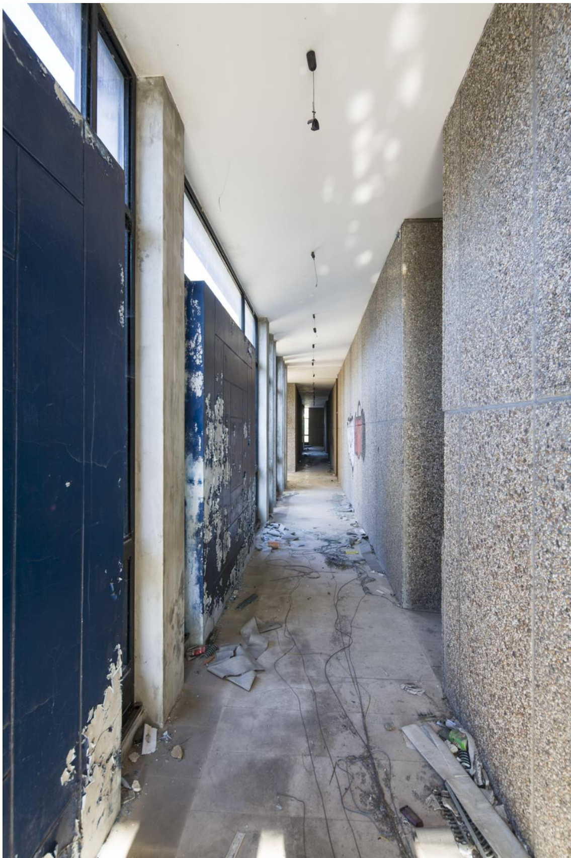
Figura 28. Corredor dos Gabinetes - Destacamento
