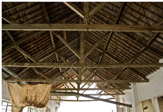
FIG. 106 | Estrutura da cobertura em madeira.
