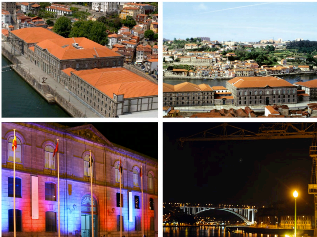
FIG. 154, 155, 156 e 157 | Centro de Congressos Alfândega do Porto - Exterior.
