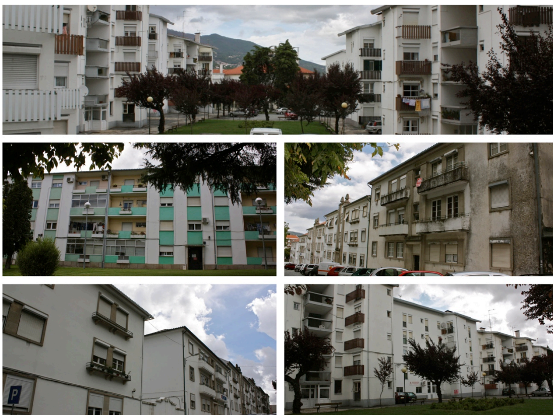
FIG. 83, 84, 85, 86 e 87 | Bairro da Estação, actualmente.
