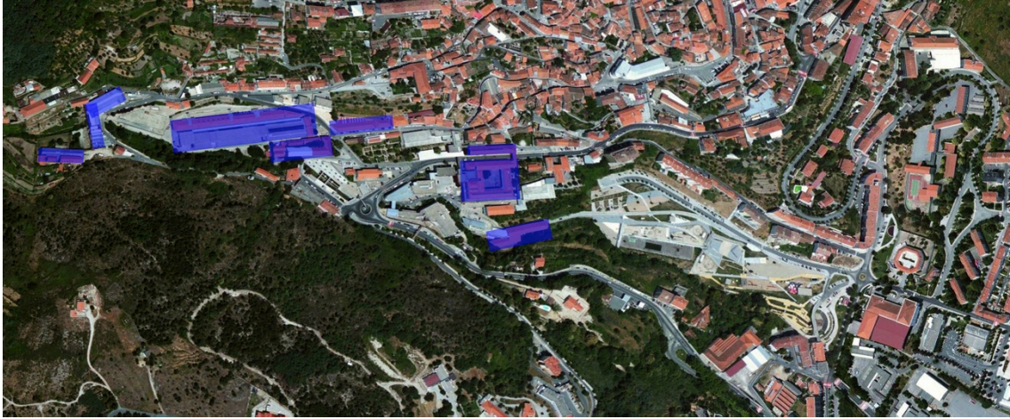
FIG. 61 | Edifícios Industriais - Ribeira da Goldra.
