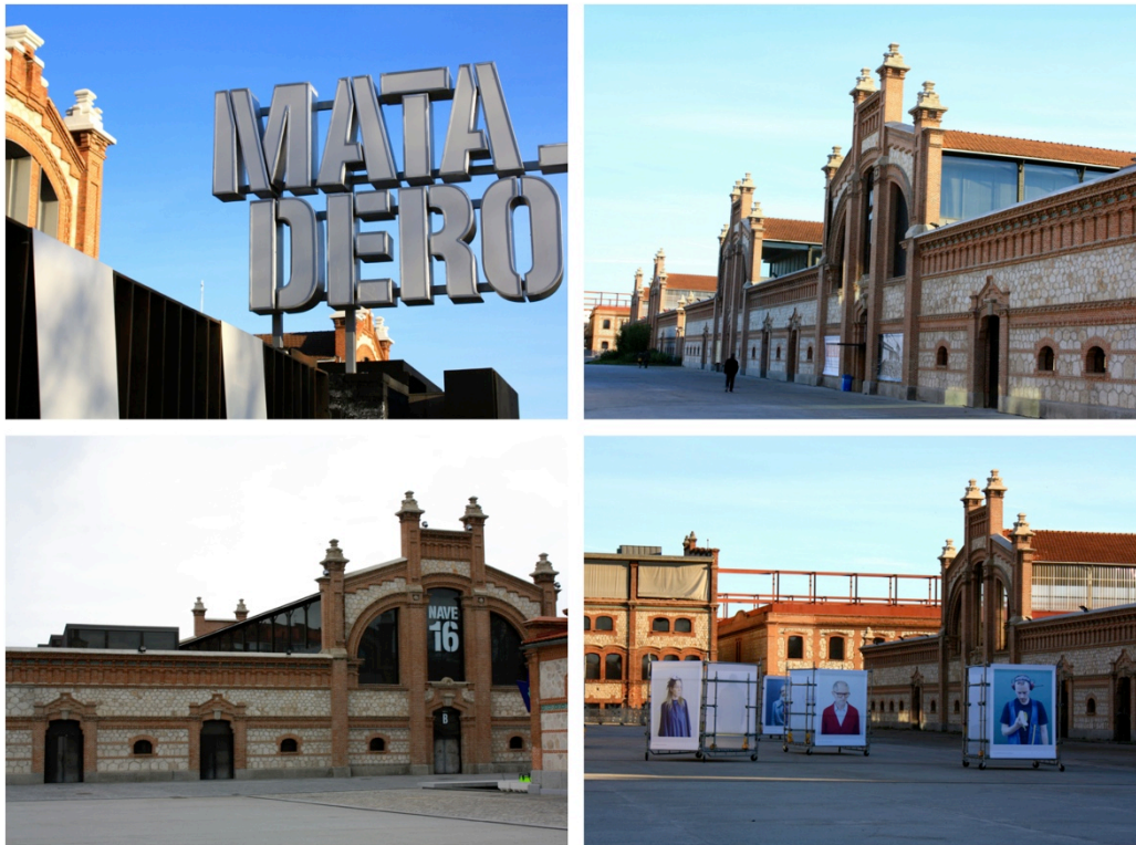
FIG. 122, 123, 124 e 125 | El Matadero Madrid - Exterior.
