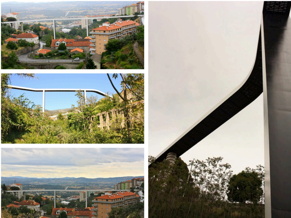
FIG. 32, 33, 34 e 35 | Ponte pedonal do Arquitecto Carrilho da Graça.
