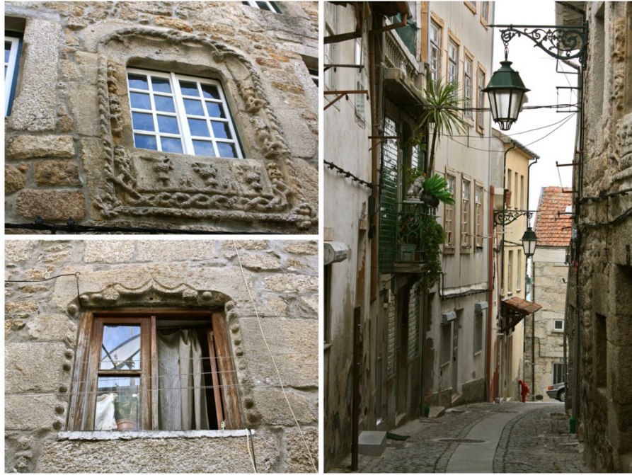
FIG. 13, 14 e 15 | Janelas manuelinas. Rua das Flores.
