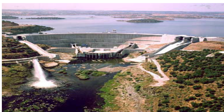
Figura 2.4 – Central de bombagem situada em Alqueva (Figura extraída de [S4]).
