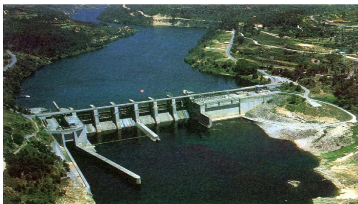
Figura 2.2 – Central de fio de água situada em Carrapatelo (Figura extraída de [S4]).
