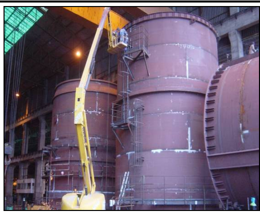
Figura 4.21 – Troços para chaminé de 85 mts de altura e 12 mts de diâmetro.
