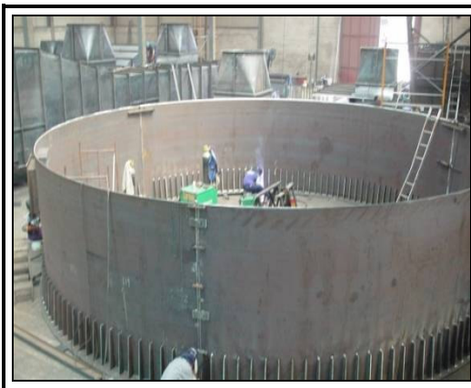
Figura 4.22 – Base de chaminé com 12 mts de diâmetro.
