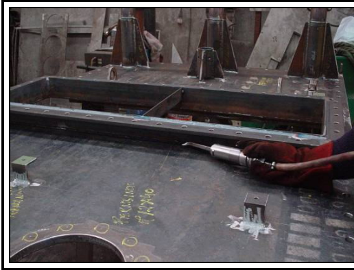
Figura 4.14 – Talhadeira pneumática de limpeza da soldadura.
