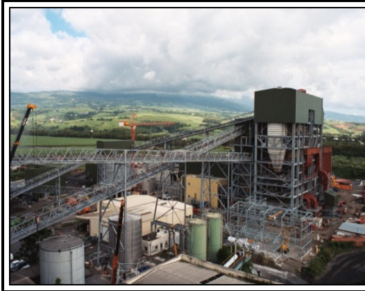
Figura 4.30 – Estrutura, transportadores e condutas (Iha de Reunião, Oceano Indico).
