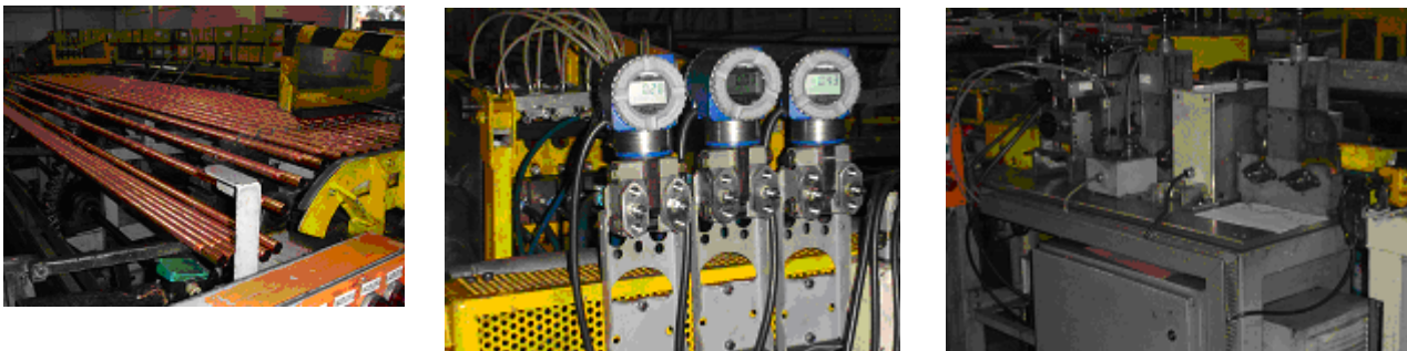
Figura 11.9. – Máquina de Acabamento.
