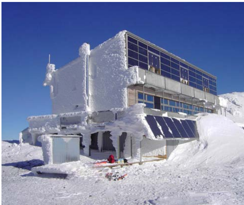
Figura 5.2 - Schiestlhaus - Fachada Sul incorporada de painéis solares e fotovoltaicos (TH, 2010b)
