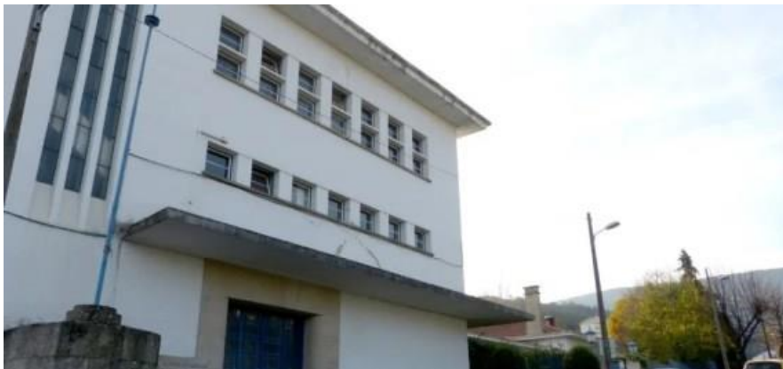
Figura 41. Antigo SMAS (Serviços Municipalizados da Covilhã) (Rádio Covilhã, 2022)
