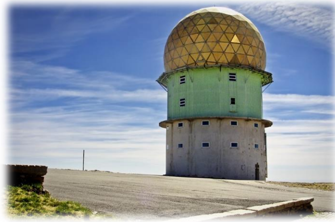
Figura 18 - Torre de radar da Serra da Estrela onde foram realizados os testes para este estudo.
