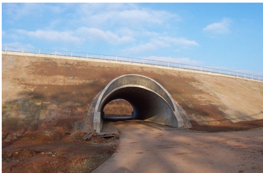
Figura 1.1 Estrutura enterrada - Passagem inferior ( http://fr.structurae.de )
