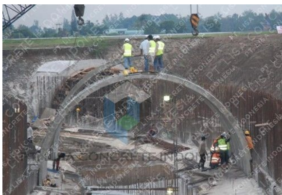
Figura 3.9 Montagem de arco único ( http://www.precastpicture.com )
