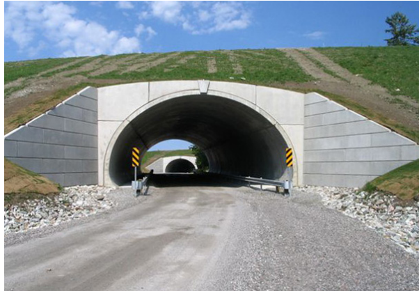
Figura 4.18 Aplicação da tecnologia Matière ( http://www.betonprovincial.com )
