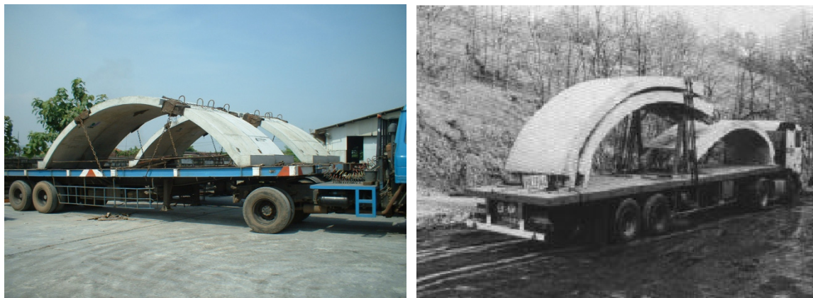
Figura 3.8 Transporte dos diferentes tipos de aduelas ( http://www.lisaconcrete.com ) (Ferraz e tal., 2000)
