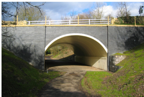
Figura 3.4 Arco formado por uma aduela ( http://www.reinforcedearth.co.uk )
