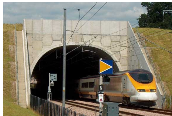
Figura 3.5 Arco formado por duas meias aduelas ( HTTP://WWW.REINFORCEDEARTH.CO.UK )
