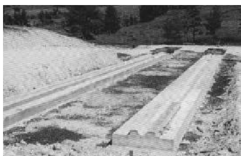
Figura 3.6 Execução das fundações in situ (Ferraz et al. , 2000)
