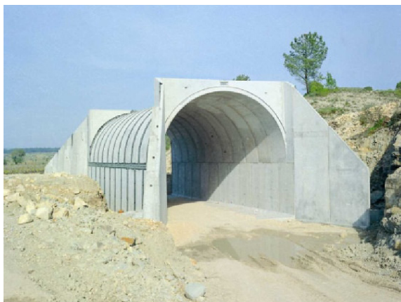
Figura 3.2 Sistema constituído por parte inferior de box culvert e arco ligados em zona perpendicular (Saraiva, 2010)
