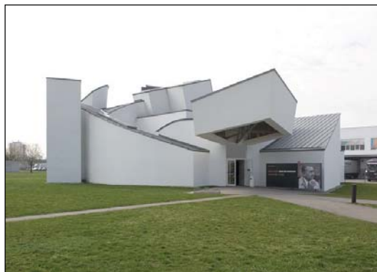
Figura 80 - Vista da Entrada Principal.
