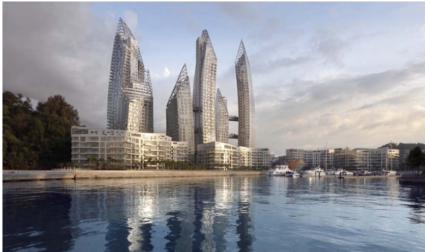
Figura 78 - Vista dos Edifícios de baixa altura e das Torres “ondeantes”.
