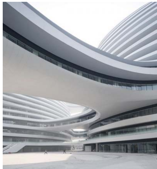
Figura 107 - Pormenor dos Passadiços.
