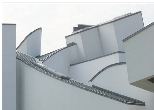
Figura 81 - Pormenor da Cobertura.
