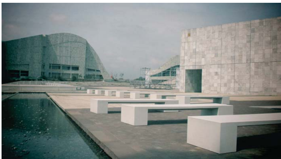
Figura 95 - Vista dos Espaços Exteriores.
