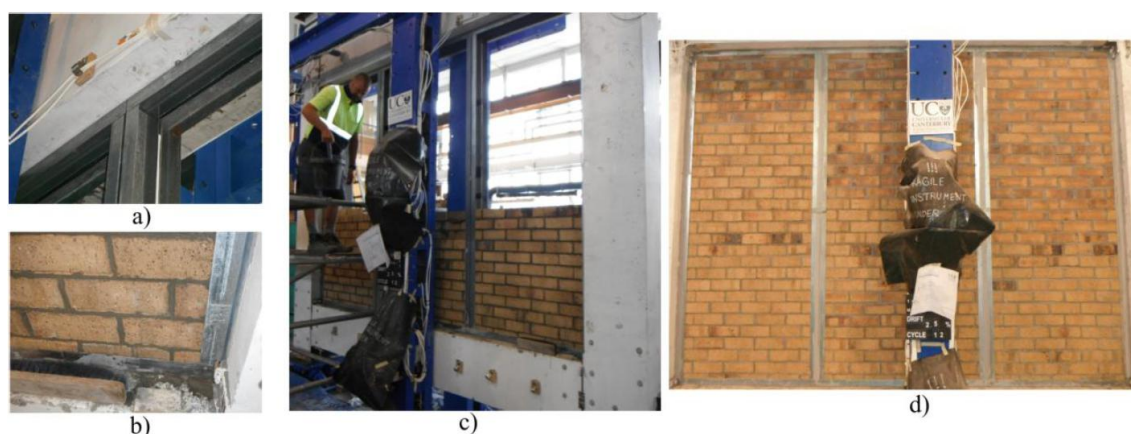
Figura 29 Construção de baixo danos. a) Subestrutura em aço leve; b e c) tijolos assentados dentro da subestrutura em aço leve; d) parede de alvenaria com vedantes de poliuretano aplicados nas juntas/espacos. Adaptado de [23]
