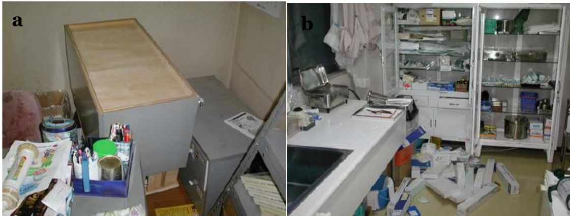
Figura 24 Tombamento de armários (a) e queda de matérias dos armários (b). Adaptado de [42]
