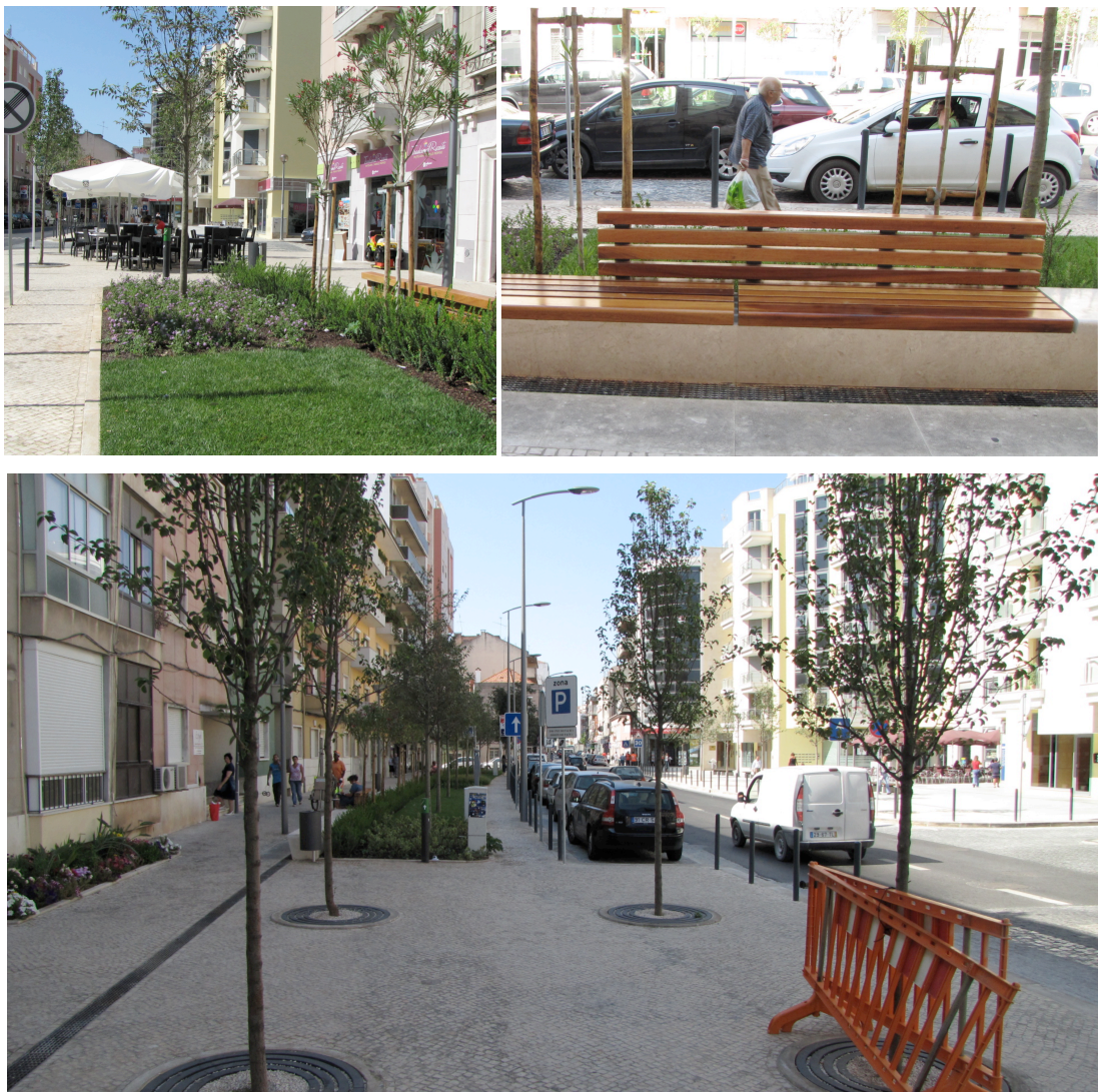
Fig. 12 - Rua Alves Redol, Vila Franca de Xira.
