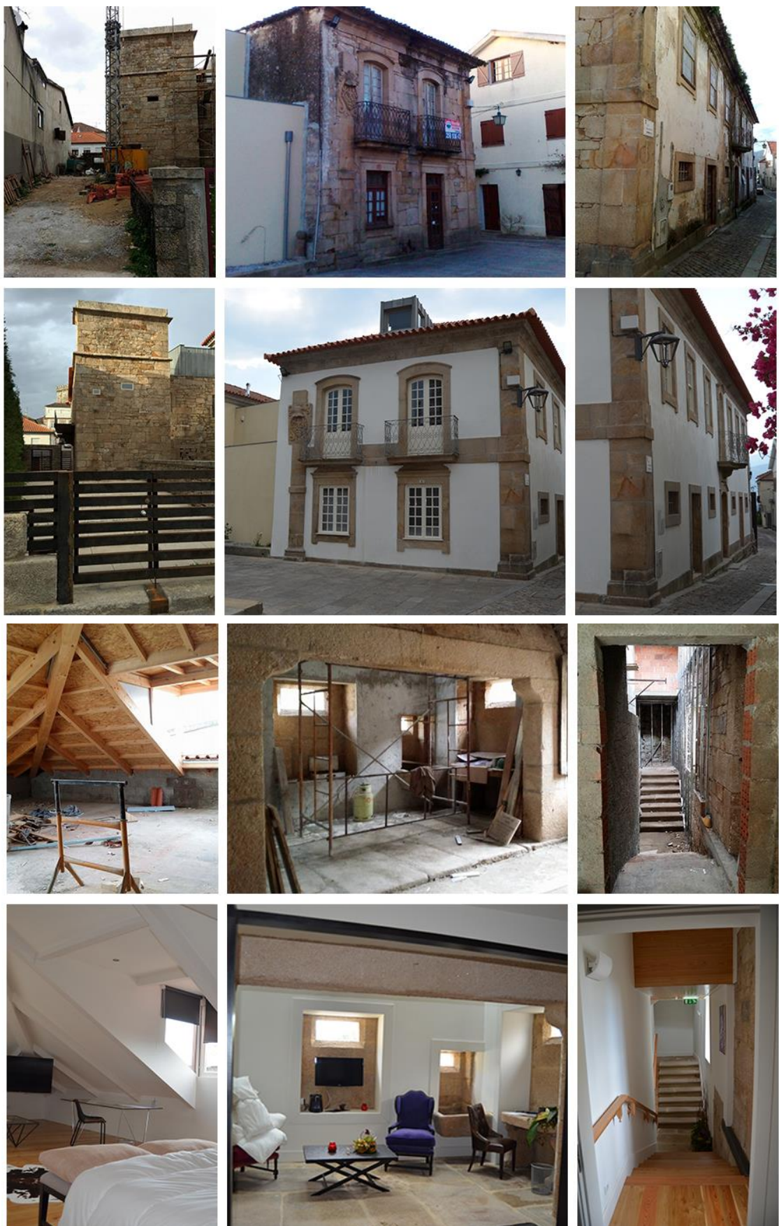
Figura 17 | Processo de reabilitação do Solar do Castelo.
