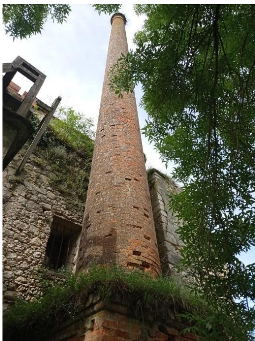
Figura 32 - chaminé em tijolo burro agregada ao Mosteiro de Santa Maria de Seixa
