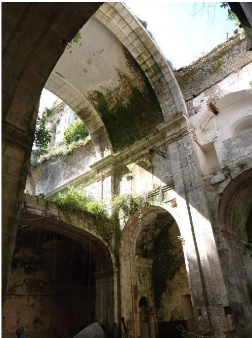
Figura 30 - arcos torais - cobertura da Igreja de Santa Maria de Seíça
