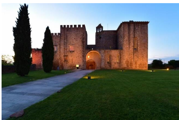
Figura 11 - fachada principal, do mosteiro Flor da Rosa
