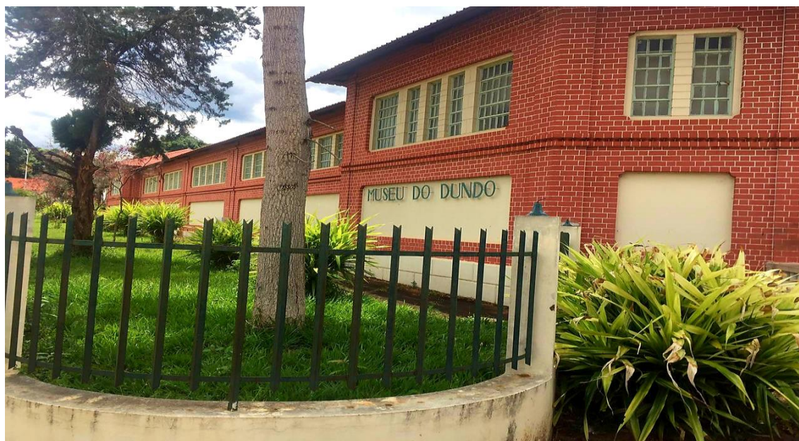
Figura 3- Museu do Dundo, no dia 20/03/202, edifício que foi construído em 1936, pela antiga companhia Diamang ou Endiama. 319
