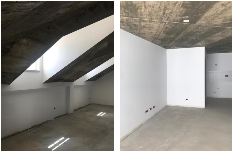
Fig. 81 – Imagem da fachada principal do edifício em julho de 2023 (em cima) e fotos de alguns acabamentos do interior do edifício. (Arquivo pessoal de Ana Cunha, 2023)
