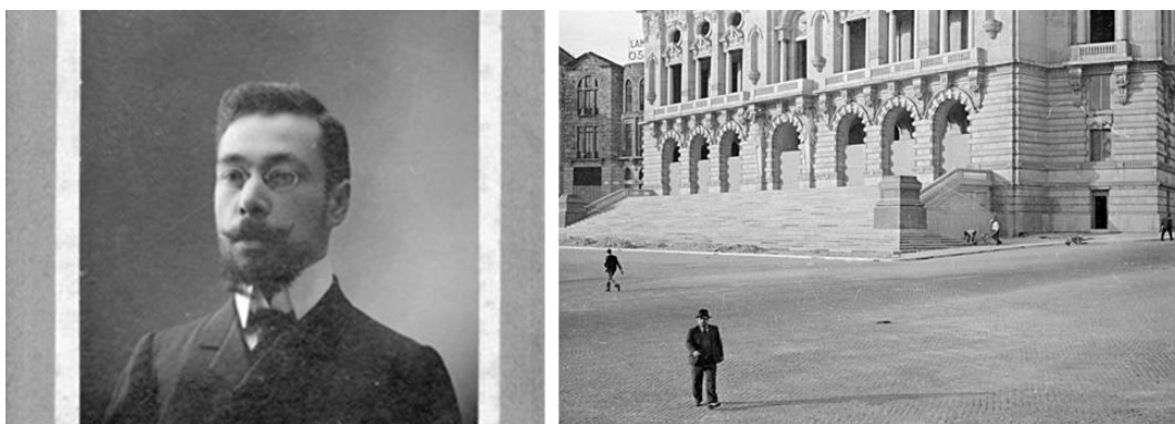
Fig. 29 - António Correia da Silva (1880-1963), arquiteto municipal portuense, 1907 (Tavares, 2016, p. 7). Fig. 30 - Escadaria exterior de ligação à futura Praça do Município em fase a acabamentos (Tavares, 2016, p. 183)
