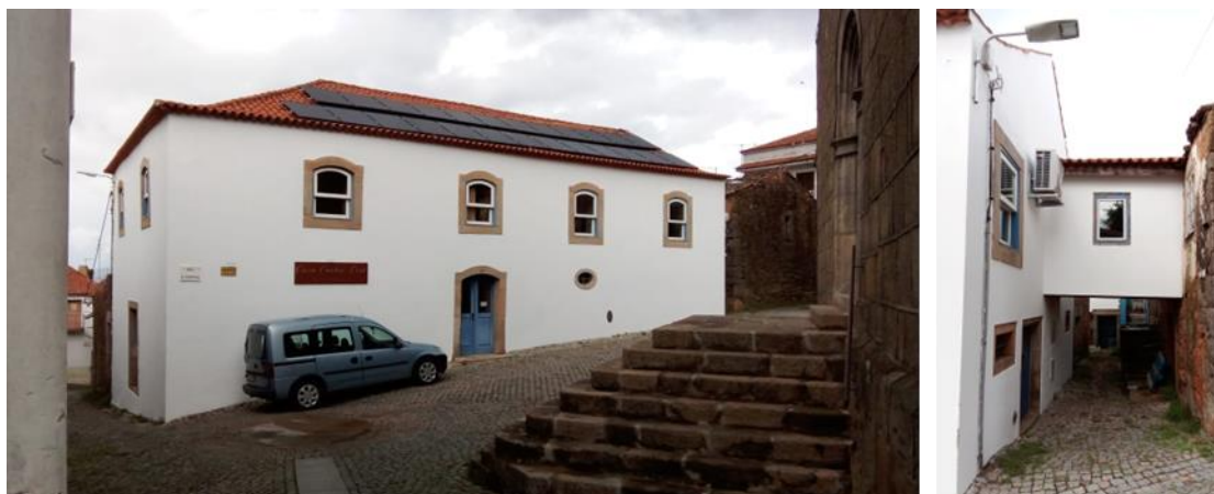
Fig. 67 - Fachada principal da Casa Cunha Leal, Rua Eng.º Cunha Leal. Alcaide; Fig. 68 – Alçado lateral direito na atualidade. (Ana Neto, setembro 2023)
