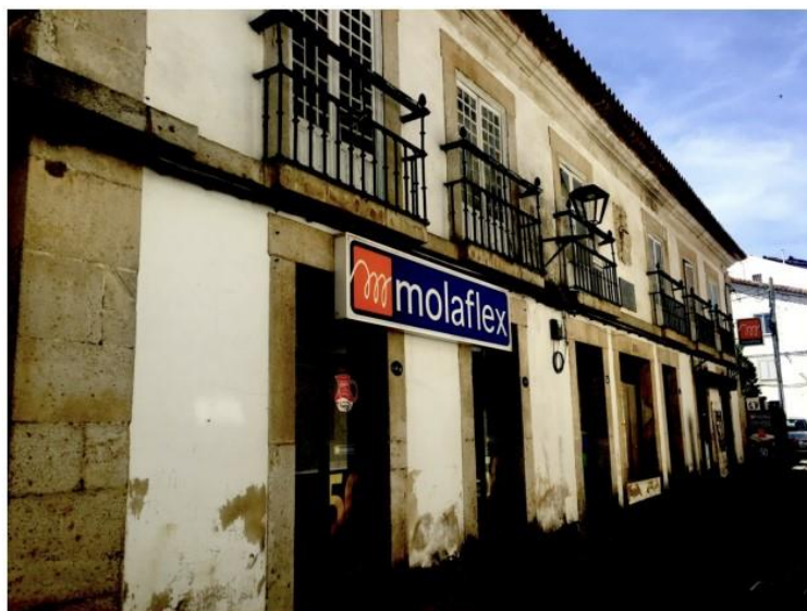
Fig. 83 - Fachada principal do Colégio de Santo António na Rua da Cale, antes da intervenção. (Cunha et al., 2017, p. 48)
