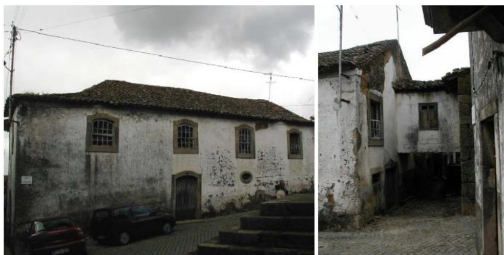
Fig. 65 - Fotografia da fachada principal do imóvel antes da intervenção. Fig. 66 – Alçado lateral direito. (Cunha, 2017)
