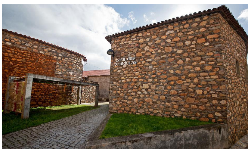
Fig. 53 – (Esq.) Tear de rua; (Dir.) Casa das Tecedeiras na Aldeia do Xisto de Janeiro de Cima, Fundão, Castelo Branco. (NM, 2014)
