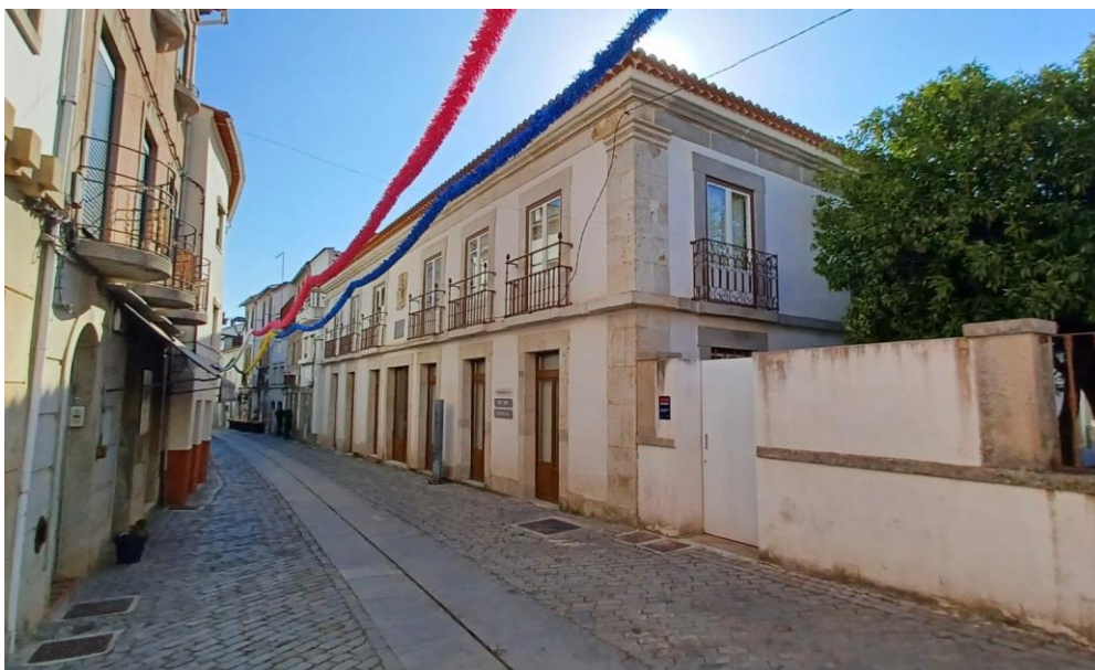
Fig. 85 - Fachada principal do Colégio de Santo António na Rua da Cale na cidade do Fundão, após intervenção. (Ana Neto, agosto 2024)
