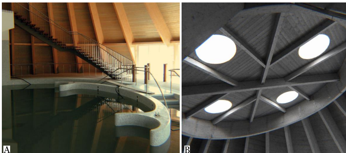
Figura 3.7 (A) Piscina lúdica interior e (B) sua cobertura da forma cónica, do Balneário das Termas do Cró (Abreu, 2008)
