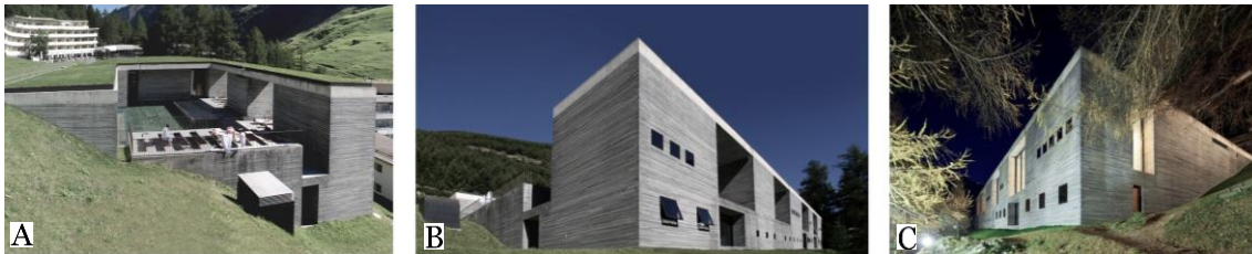
Figura 3.13 Termas de Vals: (A) Fachada a Sul (Arquiscopio, 2012), (B) Fachada a Este (Flickr, 2005) e (C) Fachada a Norte (TagesWoch, 2005)
