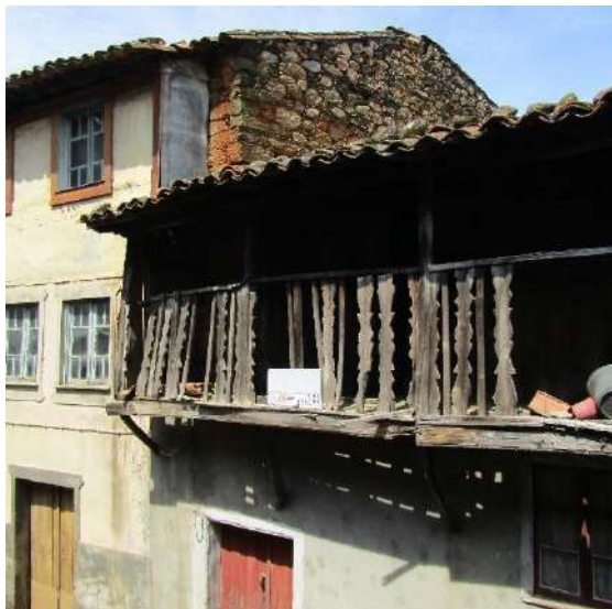
Fig. 94 - Varanda de madeira; Travessa da Lameira, Paúl (Covilhã), 2018
