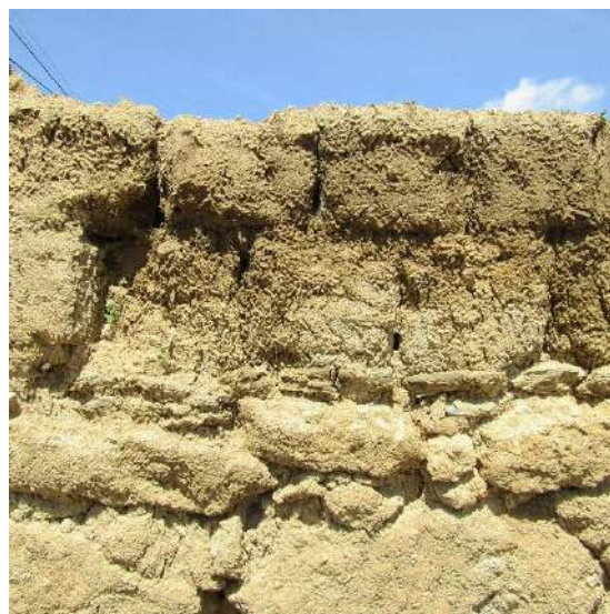
Fig. 37 - Adobe (pormenor); Rua da Zebreira nº43, Ladoeiro (Idanha-a-Nova), 2018
