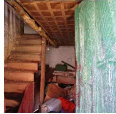
Fig. 43 - Interior; Rua Capitão João Boavida n.º8, Zebreira (Idanha-a-Nova), 2018
