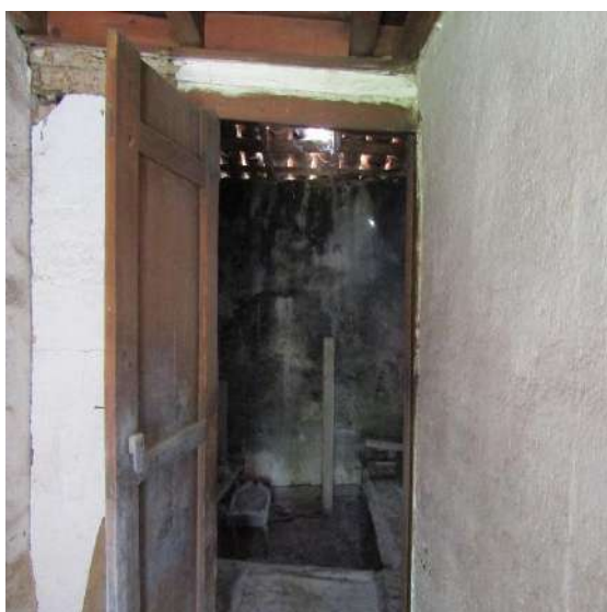
Fig. 57 - Vestíbulo; queilha entre a Rua do Poço Novo e a estrada M550, Freixial do Campo (Castelo Branco), 2018
