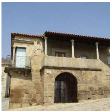
Fig. 74 - Casa seiscentista; Rua de S. Bráz, Castelo Novo (Castelo Branco), 2018
