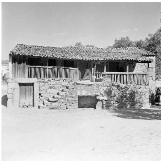
Fig. 61 - "Casas com varanda orientada a sul"; Freixial do Campo, 1955
