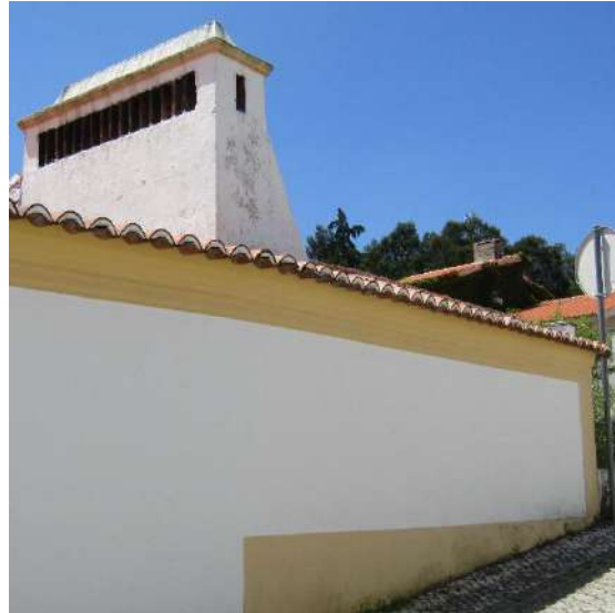
Fig. 106 - Chaminé do Museu Municipal de Vila de Rei; Rua Direita, Vila de Rei (Castelo Branco), 2018
