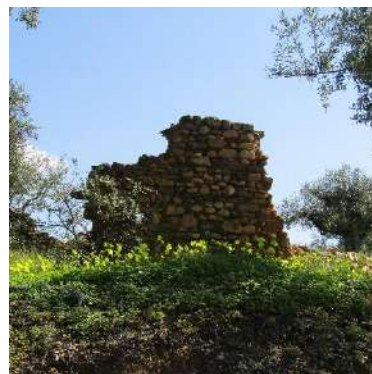
Fig. 25 - Muro; Malpica do Tejo (Castelo Branco), 2018
