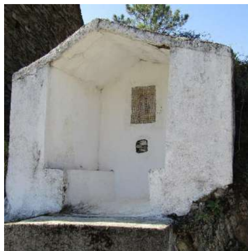
Fig. 110 - Catraia; Rua da Várzea, Meãs (Pampilhosa da Serra), 2018
