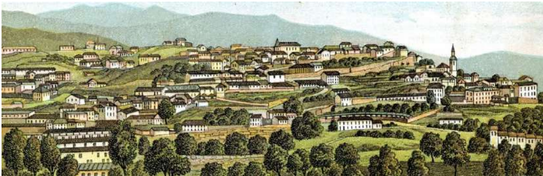
Fig. 101 - Vista parcial sobre a Covilhã, séc. XIX
