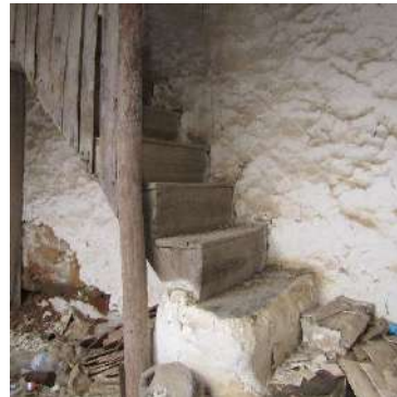
Fig. 32 - Escada interior (pormenor); Rua Nova nº21, Malpica do Tejo (Castelo Branco), 2018
