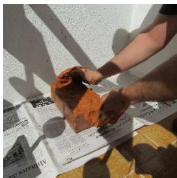
Fig. 39 - Colocação da massa no adobro, 2020
