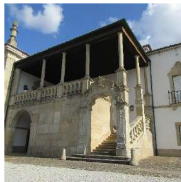
Fig. 75 - Balcão alpendrado do Paço Episcopal de Castelo Branco; Castelo Branco, 2020
