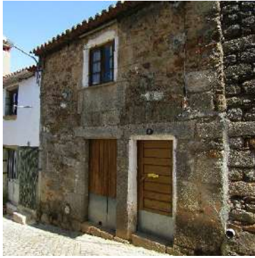
Fig. 76 - Casa; Rua de S. Pedro nº2, Alcaide (Fundão), 2018
