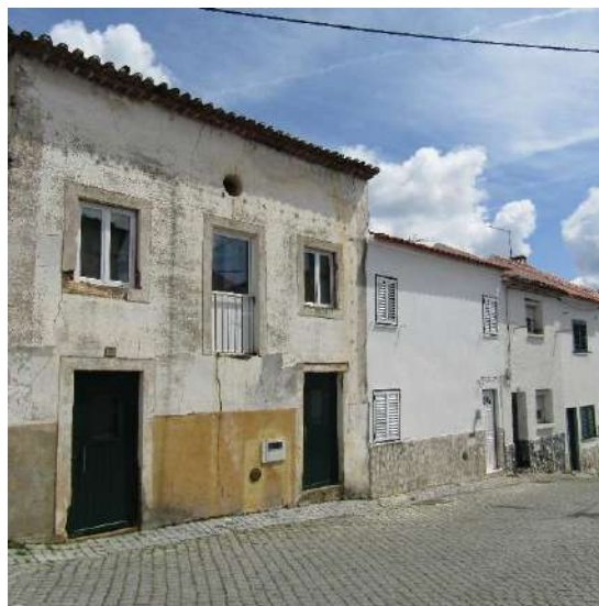
Fig. 30 - Aglomerado; Rua do Reduto, Malpica do Tejo (Castelo Branco), 2018
