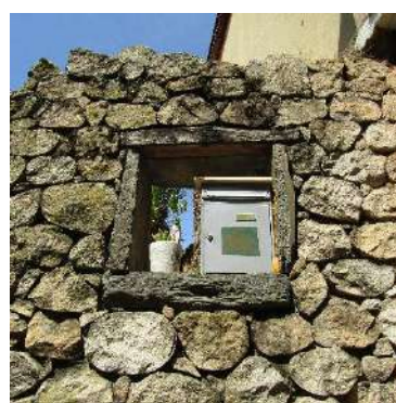
Fig. 93 - Janela (pormenor); Travessa da Lameira, Paúl (Covilhã), 2018
