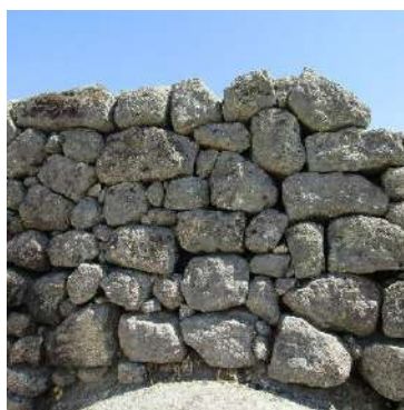
Fig. 68 - Parede em osso; Rua Maria Rosa Barata Parteira, Alpedrinha (Castelo Branco), 2018
