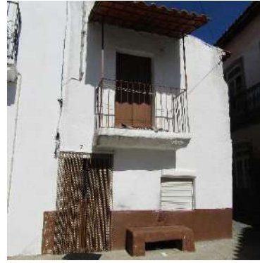
Fig. 42 - Aglomerado (pormenor) - varanda; Rua Prof. António M. Romão n.º7, Zebreira (Idanha-a-Nova), 2018
