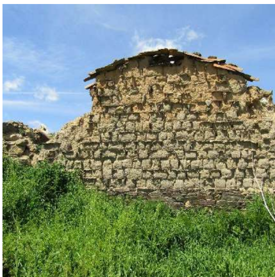
Fig. 36 - Outão em adobe; estrada M351, Ladoeiro (Idanha-a-Nova), 2018
