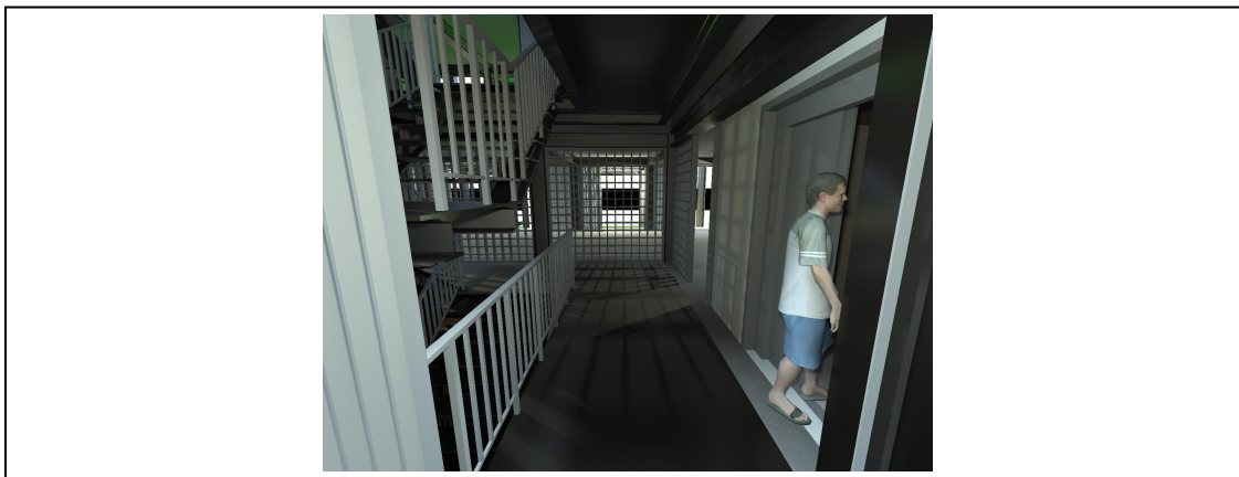
Figura 30. Escadas de estrutura metálica em aço.
