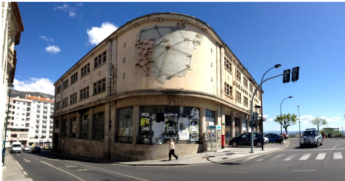
Fig. 35: Garagem de S. João, Covilhã.
