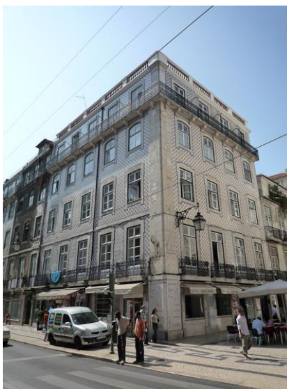
Fig. 14: Lisbon Lounge Hostel, vista exterior do edifício.
