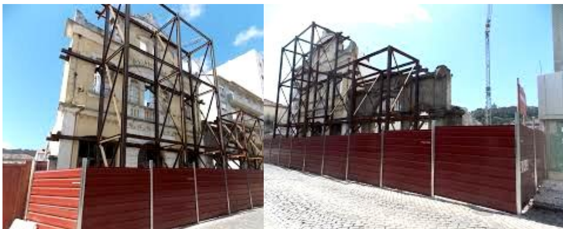
Fig. 44: Exemplo de uma fachada segura por perfis metálicos.
