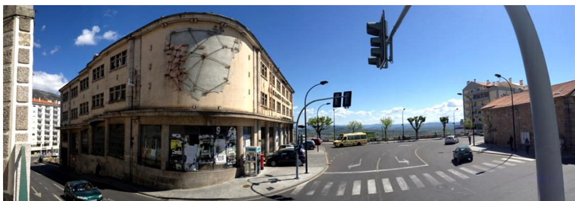
Fig. 39: Fachadas principais da Garagem de S. João.
