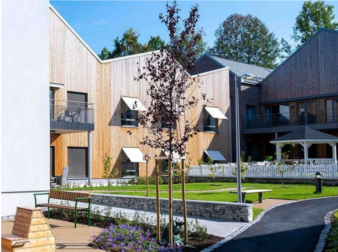
Figura 25 – Carpe Diem Dementia Village - Área comum e visão para as diferentes tipologias dos edifícios.
