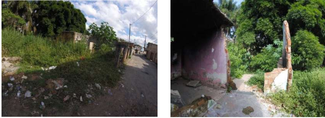
Figura 3: Margens do rio Humaitá repletas de lixos, mato, casas mal acabadas e algumas até destruídas e abandonadas (à esquerda) e casa destruída e abandonada na beira das margens do rio Humaitá, onde sede cada vez mais (à direita).
