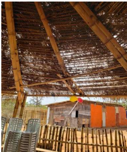
Imagem 3 – Cobertura do centro de atividades da comunidade Kariri-Xocò.
