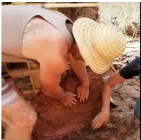
Imagem 6– preenchimento das paredes
