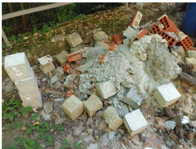
Figura 2.4. Resíduos de betão utilizados para reciclagem
