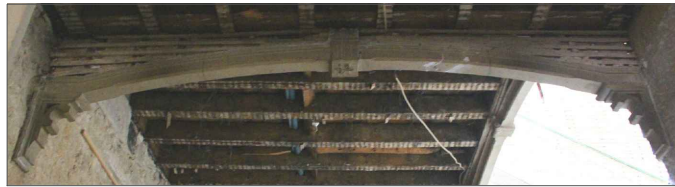
Imagem 163 - Levantamento fotográfico do Arco V1
