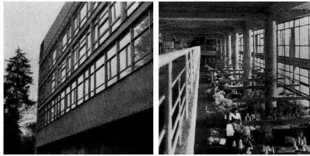
Fig. 111 Fachada da fábrica sem brise-soleil
