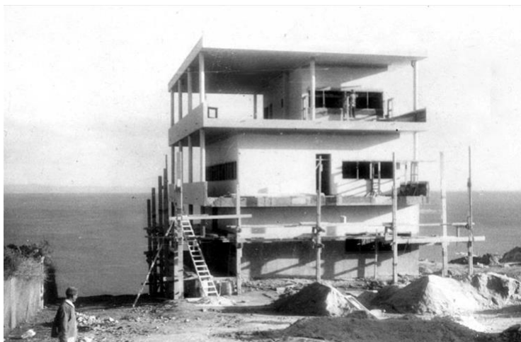
Fig. 95 Construção da Villa Baizeau
