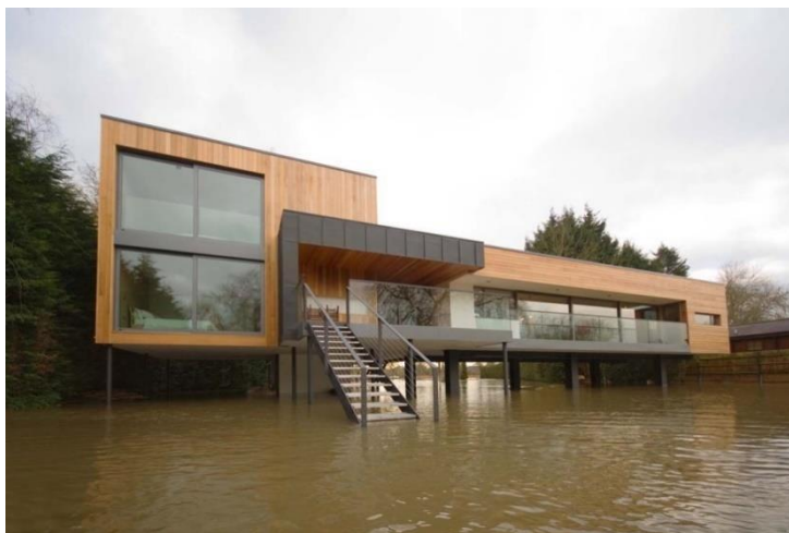
Figura 4.2 – Imagem de Hind House de John Pardey Architects (Fonte 26)
