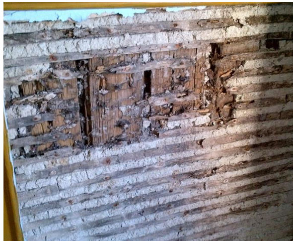
Fotografia 8 - Parede interior em tabique
