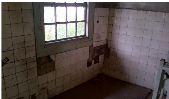
Fotografia 11 - Parede exterior com revestimento cerâmico
