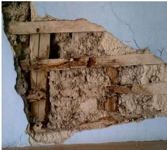
Fotografia 9 - Parede exterior em tabique
