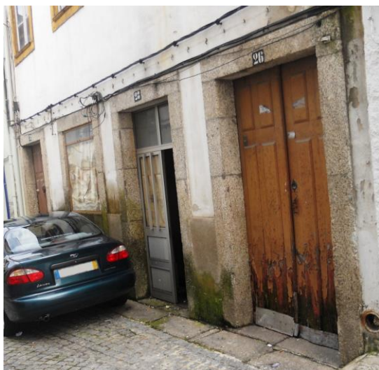
Fotografia 7 - Fachada principal, onde se pode ver a pedra que a constitui
