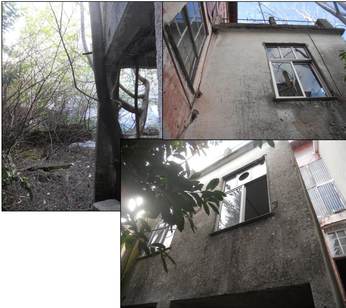
Fotografia 2 - Logradouro e anexo do edifício, Lavandaria Americana, 2013
