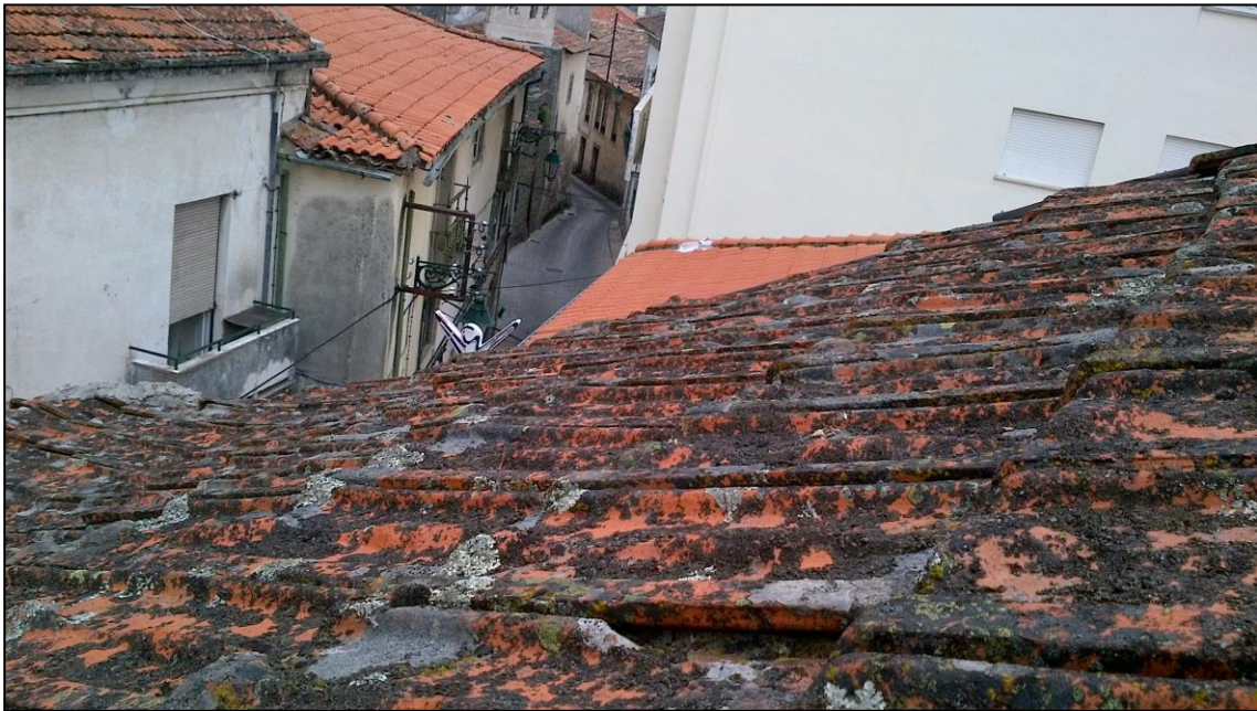
Fotografia 3 - Cobertura do edifício Lavandaria Americana, 2013
