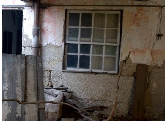
Fotografia 5 - Parede exterior da cave em granito
