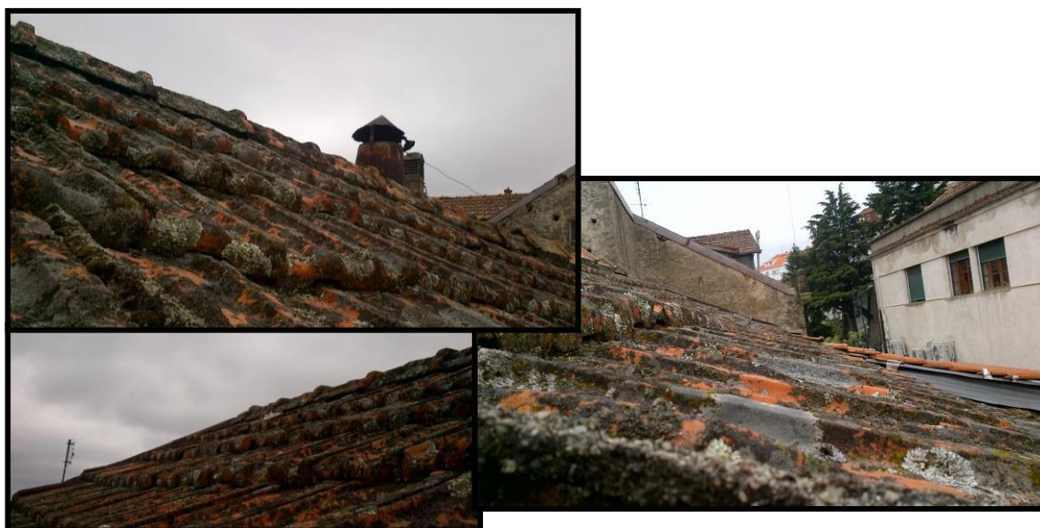
Ilustração 57 - Cobertura - Telhas Marselha
