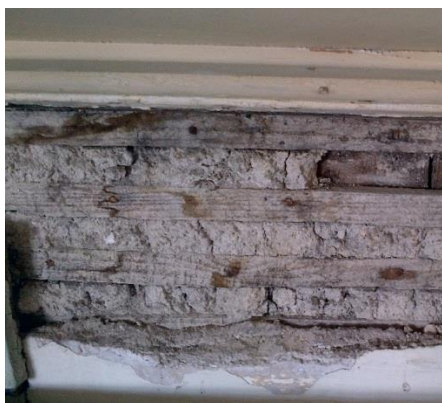
Fotografia 10 - Parede interior em tabique
