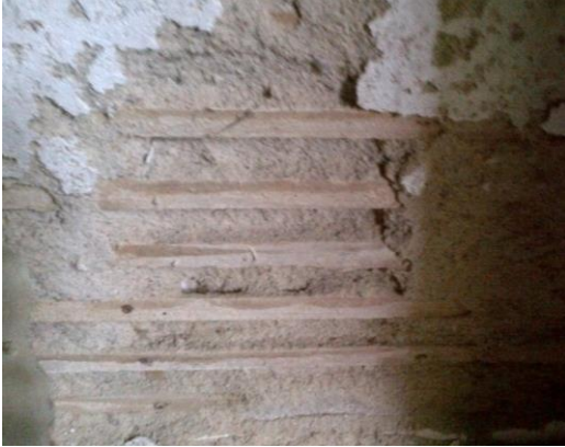
Fotografia 4 - Parede interior em tabique
