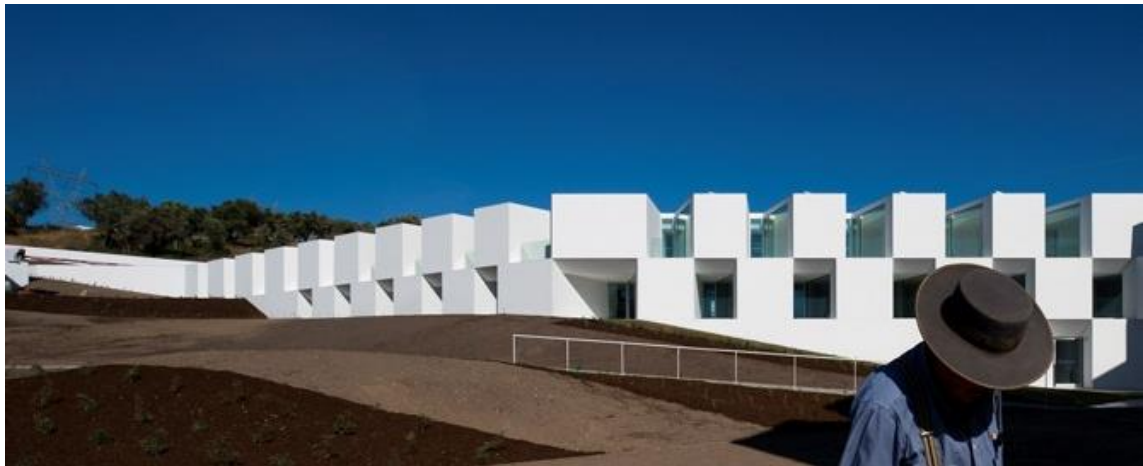
Figura 76 - Residências assistidas em Alcácer do Sal; Fonte: Arkitok, HOUSES FOR ELDERLY PEOPLE IN ALCÁCER DO SAL, 2010
