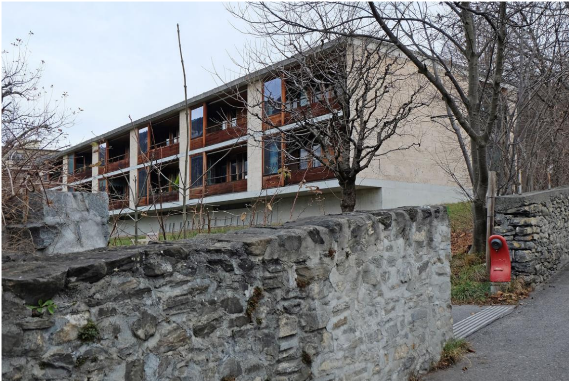
Figura 63 - Muro pré-existente; Fonte: ARCHIPICTURE.EU
