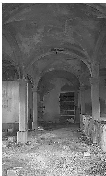
Figura 36 - Interior da Antiga adega
