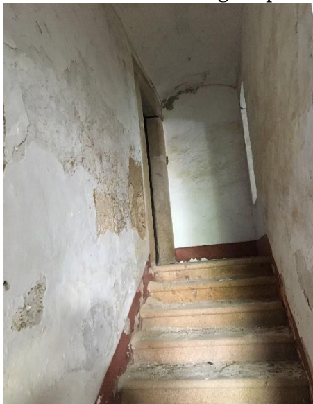
Figura 38 - Primeiro lance das escadas de acesso ao piso 1
