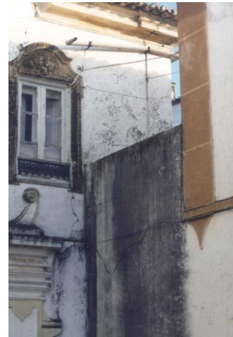
Figura 43 - Fotografia de janela
