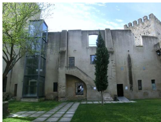
Figura 16 - Interior do Castelo de Alter do Chão após a sua recuperação
