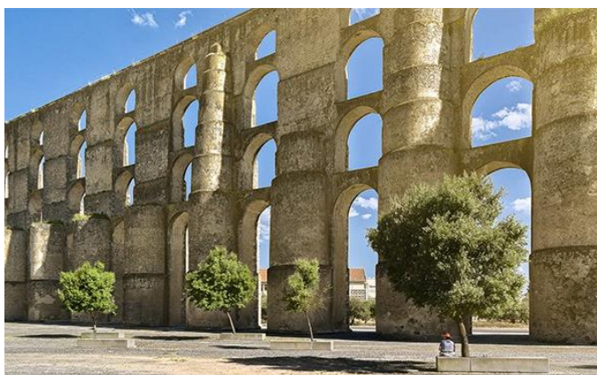
Figura 3 - Aqueduto Romano de Elvas
