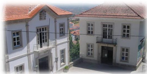
Figura 30 - Entrada Principal da ESCM
