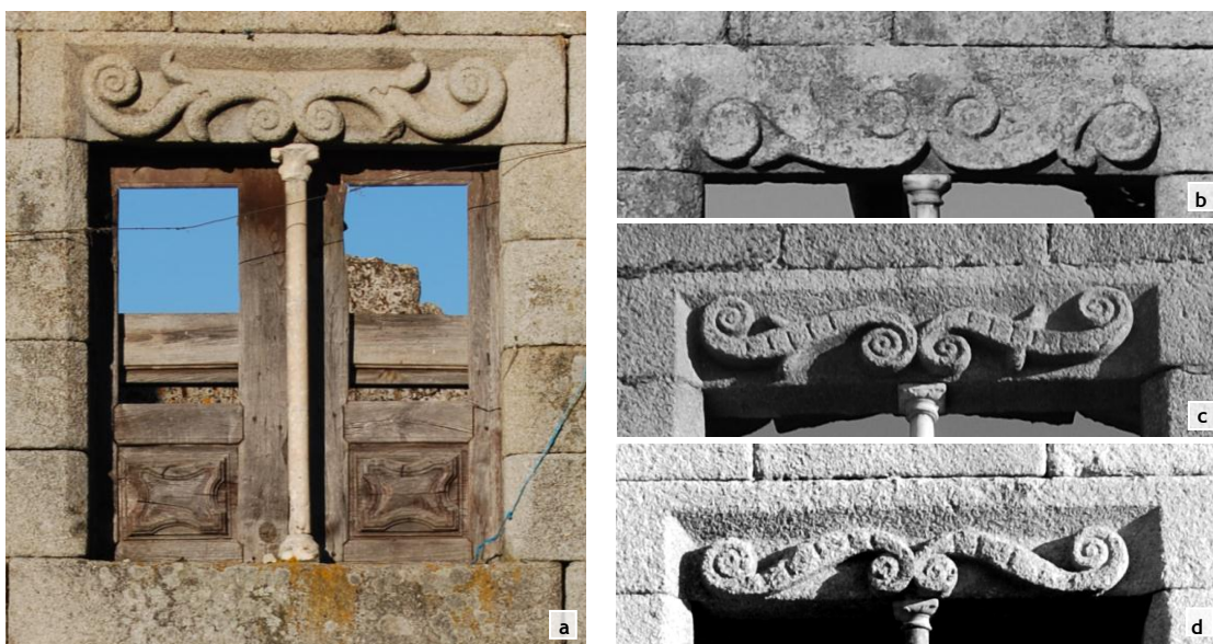
Figura 11 - Lintéis decorados por motivos fitomórficos em médio relevo: Fachada Oeste: (a) Janela central, (b) Janela do 1º piso; Fachada Norte: (c) Janela do 1º piso, (d) Janela do 2º piso
