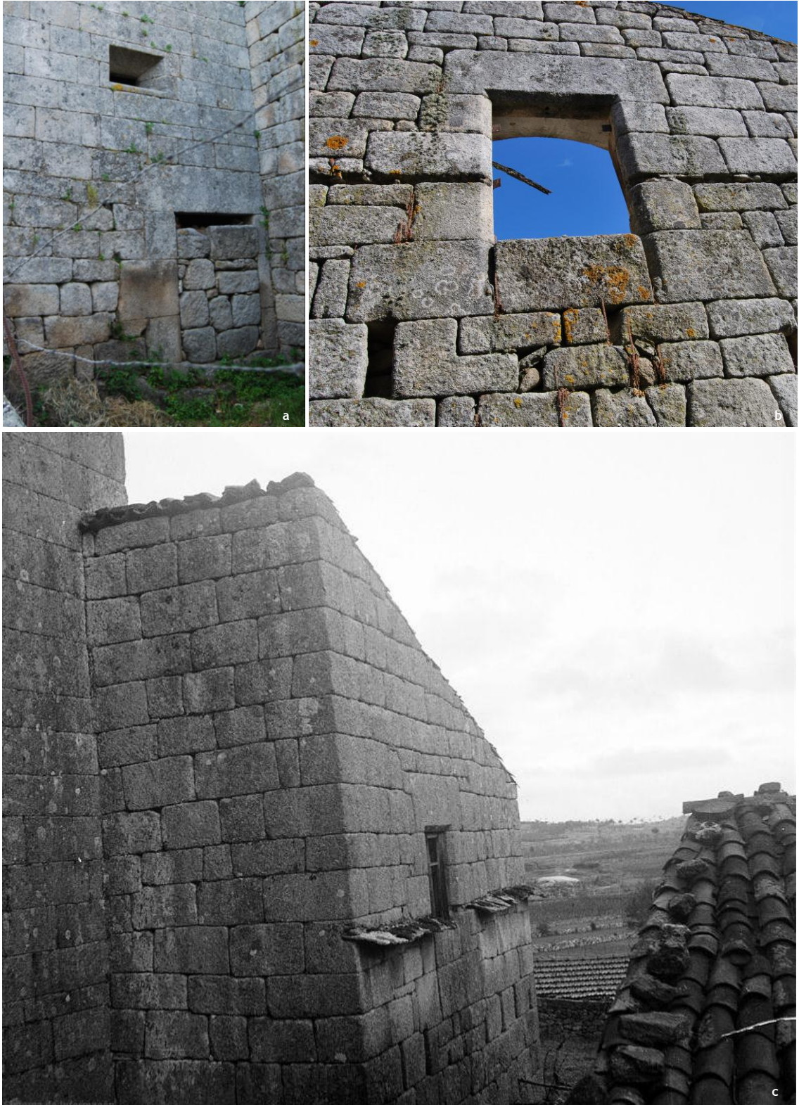
Figura 36 - Aberturas da fachada Sul: (a) Entrada; (b) Abertura,2011; (c) Janela, 1949
