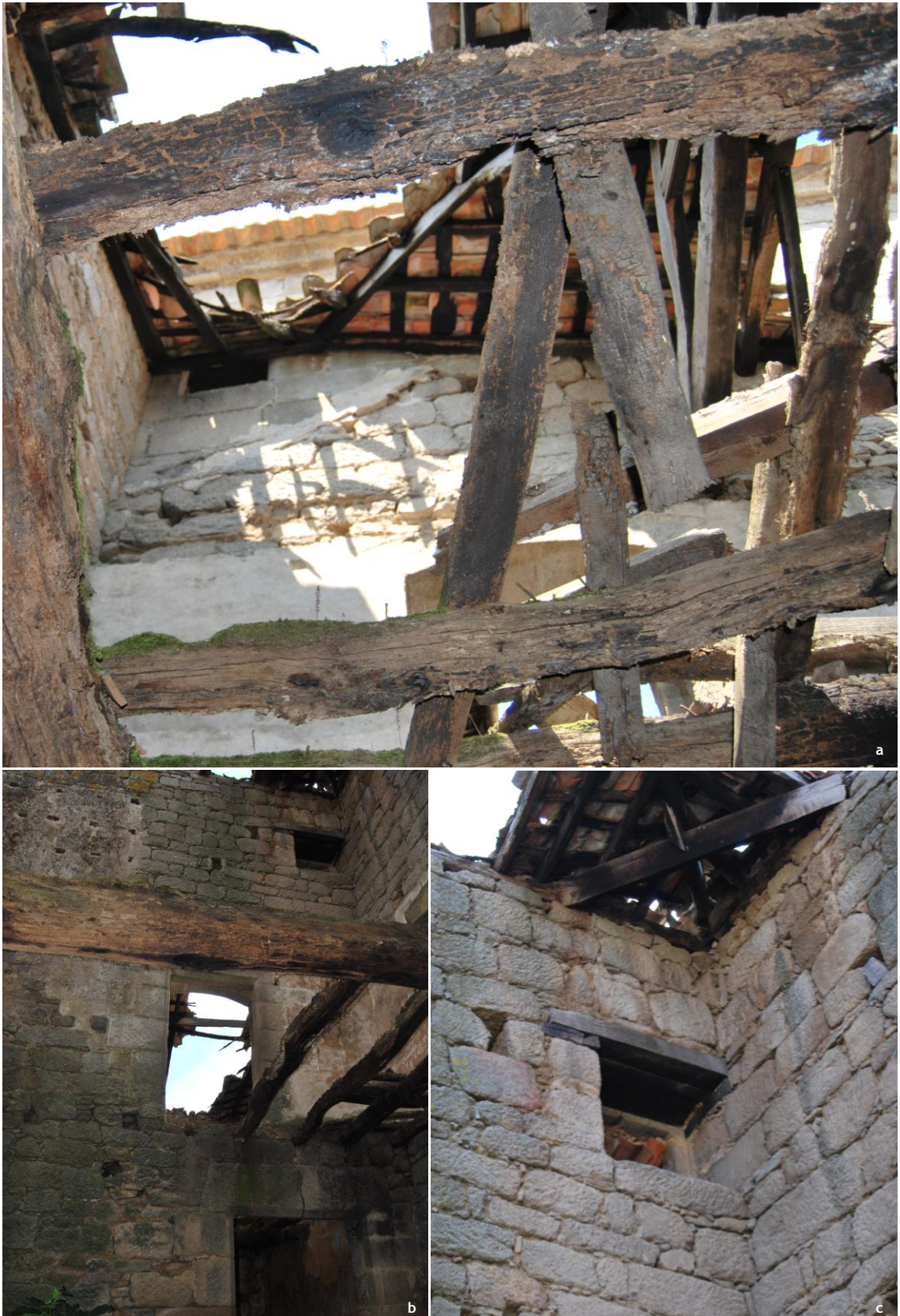
Figura 31 - (a) Marcas da antiga cobertura e Janela oculta; (b,c) Espaço interior da janela oculta
