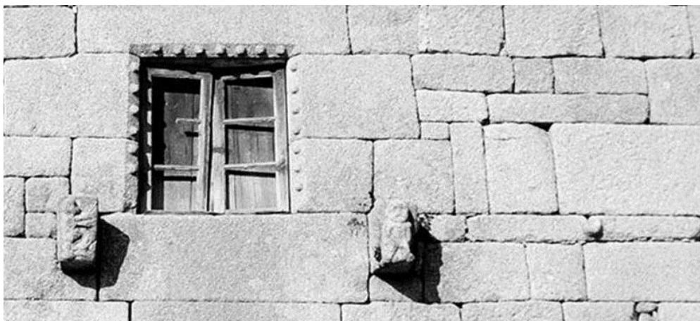
Figura 10 - Janelas da fachada Este, 1954
