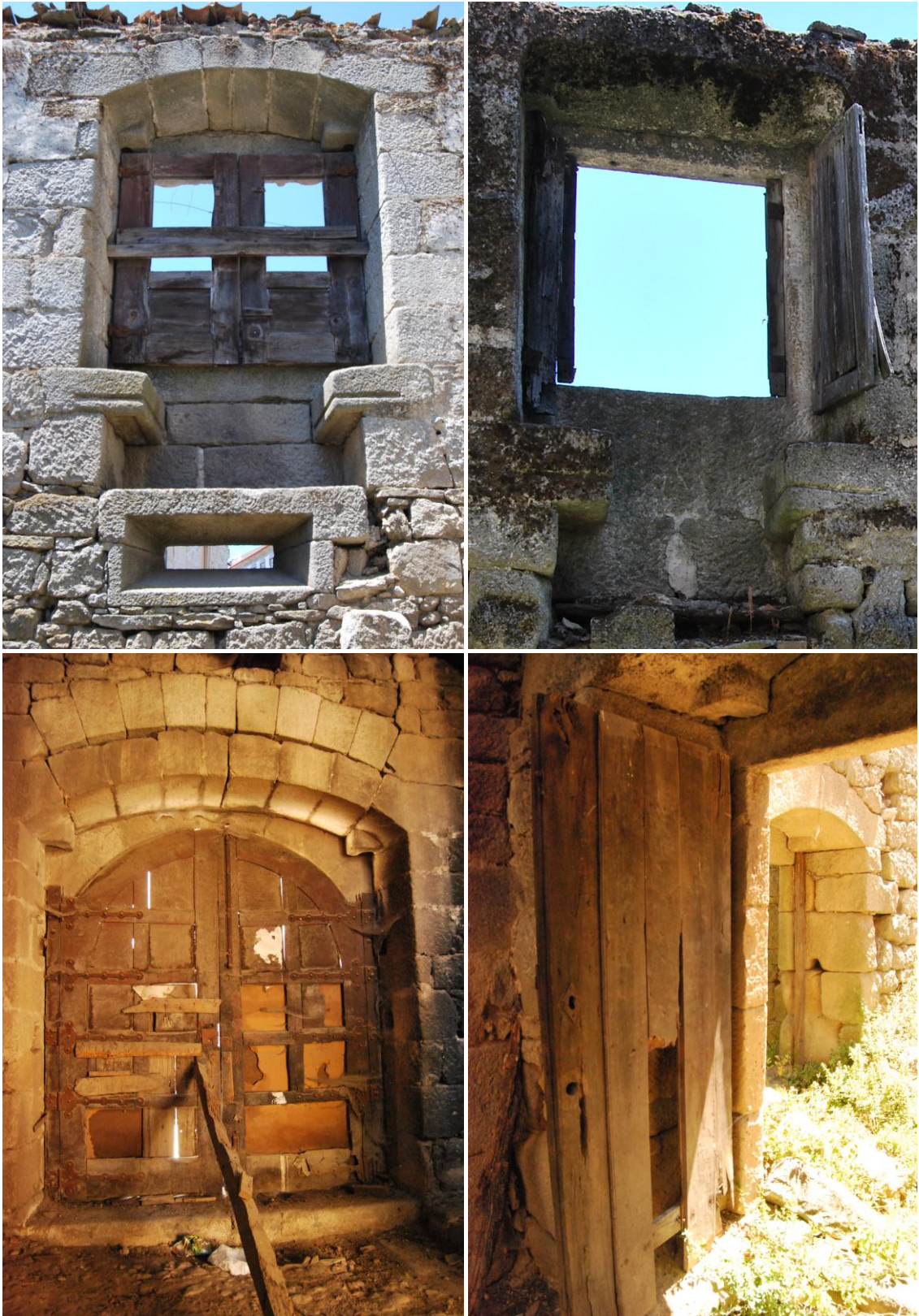
Figura 40 - Portas e janelas do Solar dos Távoras, 2011
