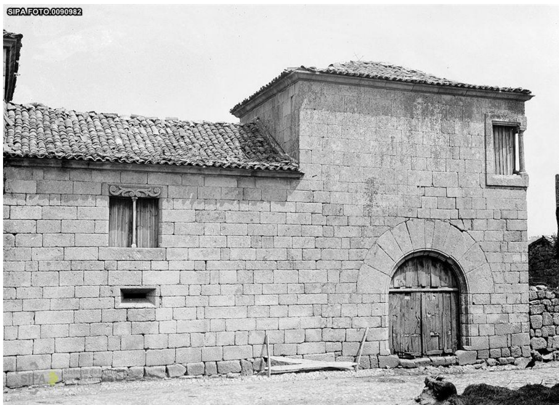
Figura 18 - O Solar dos Távoras antes das obras de conservação, 1949
