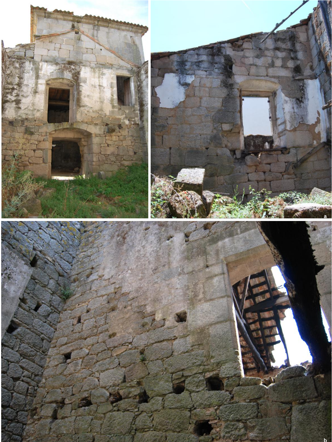
Figura 38 - (a) Vestígios de reboco pintado de branco no primeiro piso; (b) Marcas no reboco da existência de uma escada
