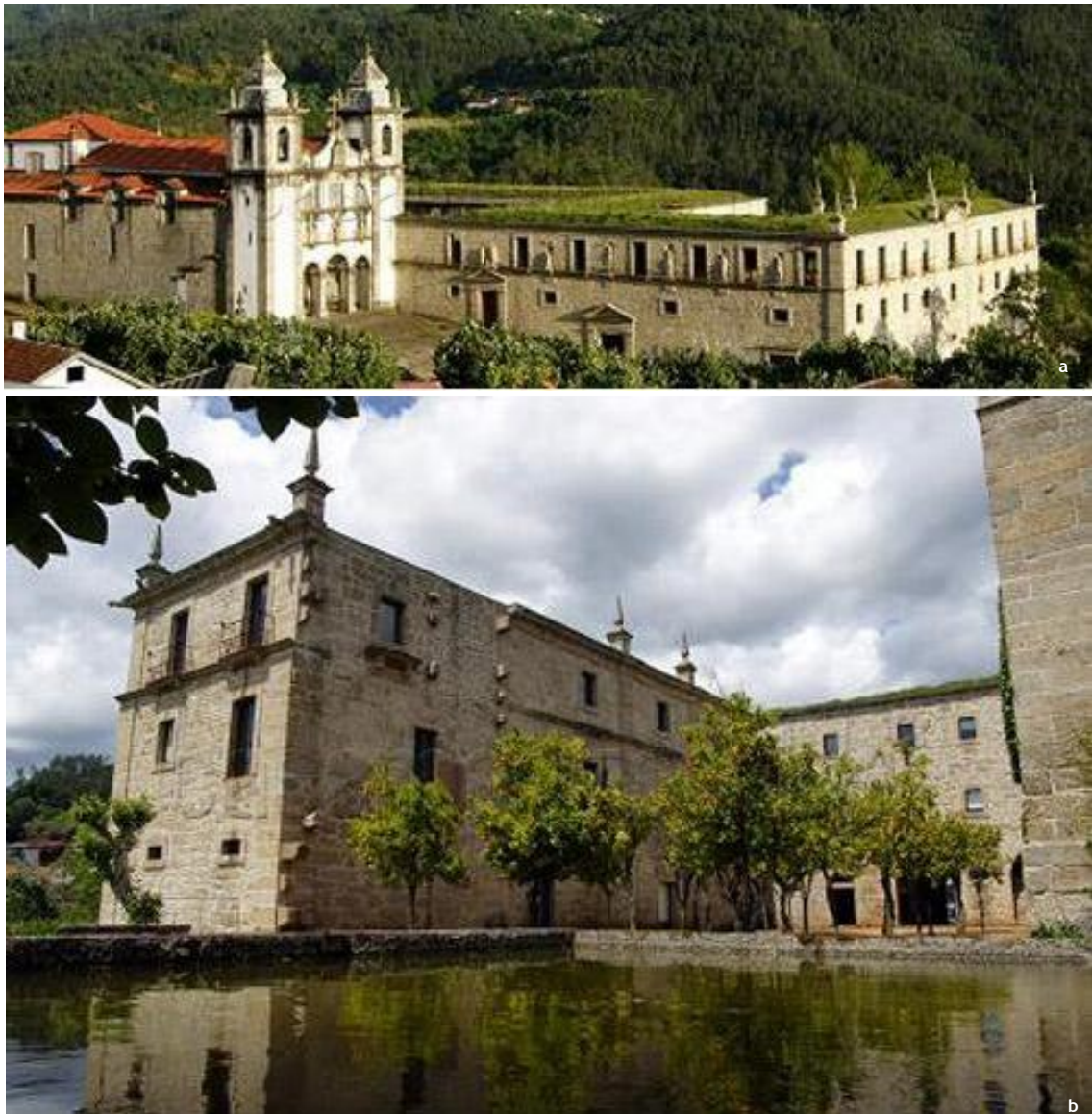
Figura 46 - Pousada Santa Maria do Bouro, Amares: (a) Perspectiva aérea do edifício; (b) Espaço central da Pousada
