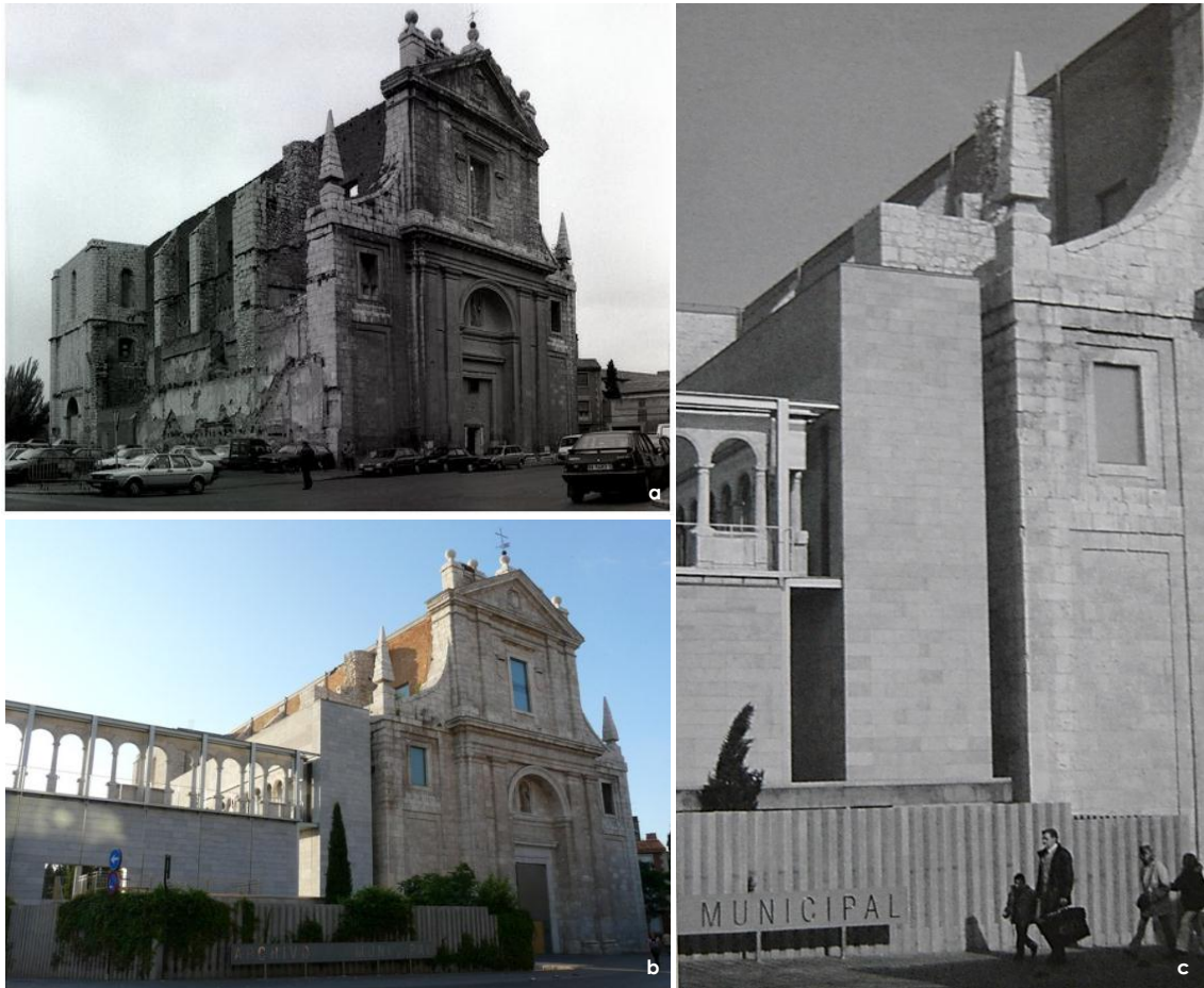
Figura 42 - Arquivo Municipal de Valladolid: (a) Ruína da igreja de Santo Agostinho; (b) Fachada principal; (c) Ligação do novo corpo ao existente
