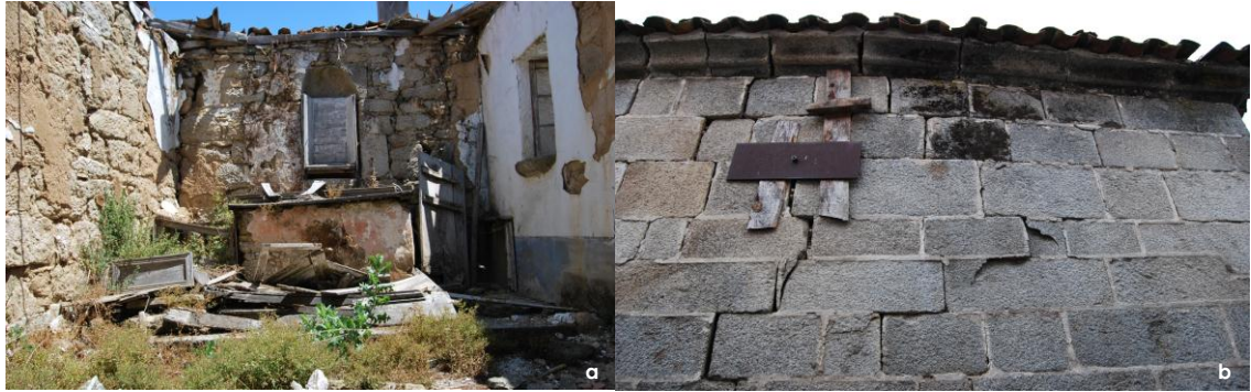
Figura 27 - Capela N. Sr.ª da Esperança; (a) Interior; (b) Parede com travamento metálico
