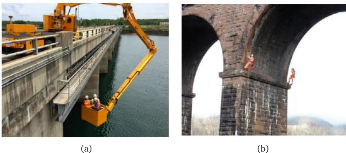
Figura 3.7 – Métodos convencionais de inspeção: Veículos especiais (a), Cordas (b) [51].
