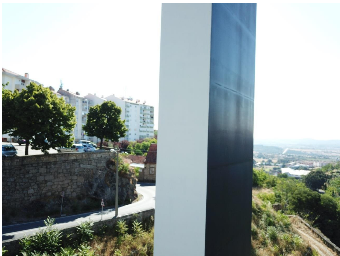
Figura 5.11 – Ponte da Carpinteira - registo dos pilares centrais da ponte.
