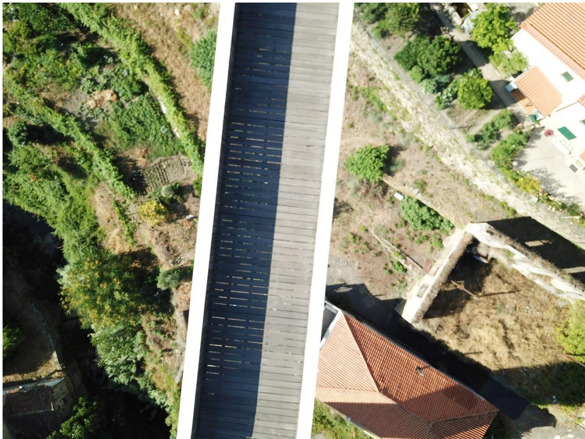
Figura 5.9 – Ponte da Carpinteira - registo da parte superior do tabuleiro da ponte.
