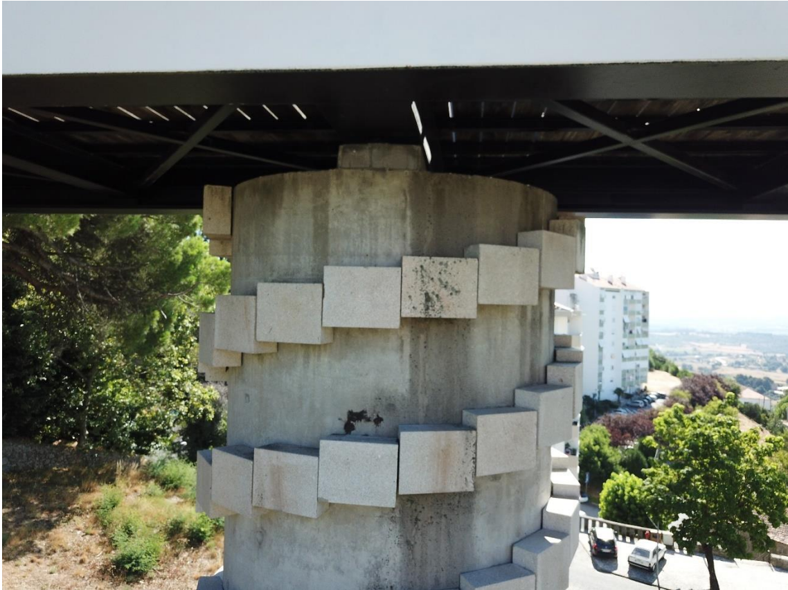
Figura 5.12 – Ponte da Carpinteira - registo dos pilares circulares em betão.
