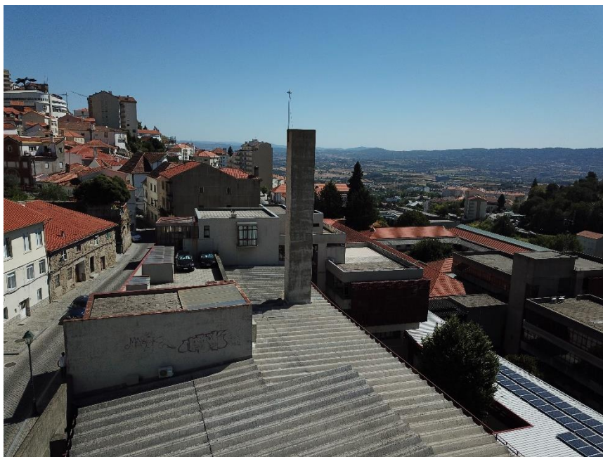
Figura 5.4 – Chaminé em betão armado do polo principal da Universidade da Beira Interior
