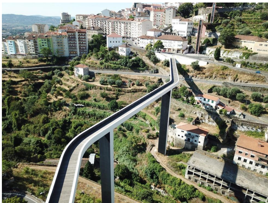
Figura 5.1 – Ponte sobre a ribeira da Carpinteira (Covilhã).
