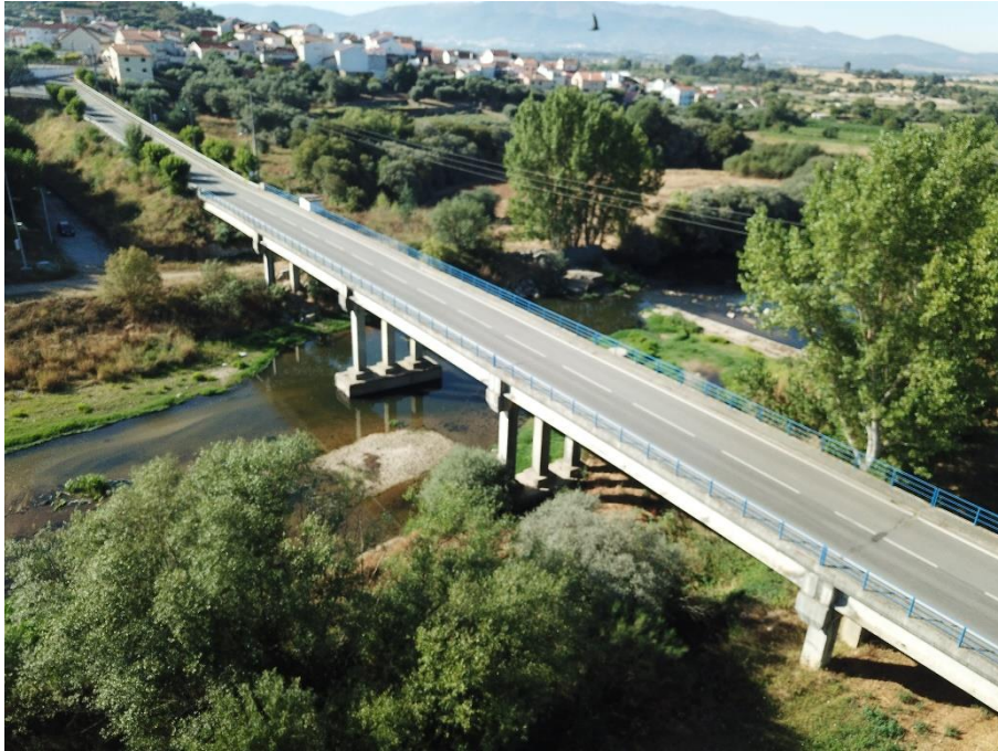
Figura 5.2 – Ponte entre o Dominguiço e Alcaria.
