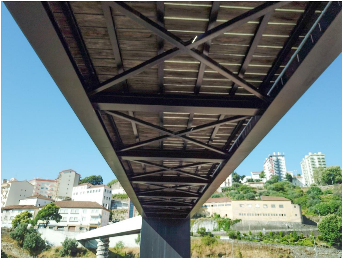
Figura 5.13 – Ponte da Carpinteira – zona inferior do tabuleiro da ponte.
