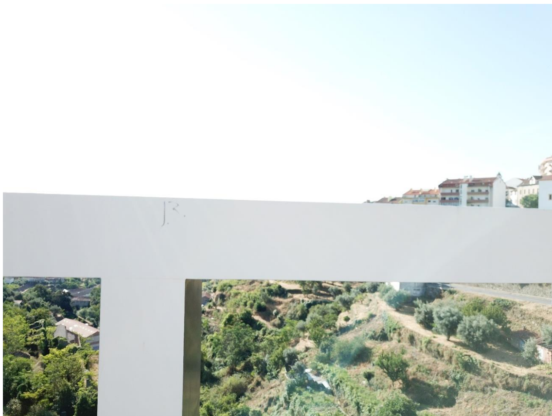
Figura 5.10 – Ponte da Carpinteira - registo da lateral voltada a poente da ponte.
