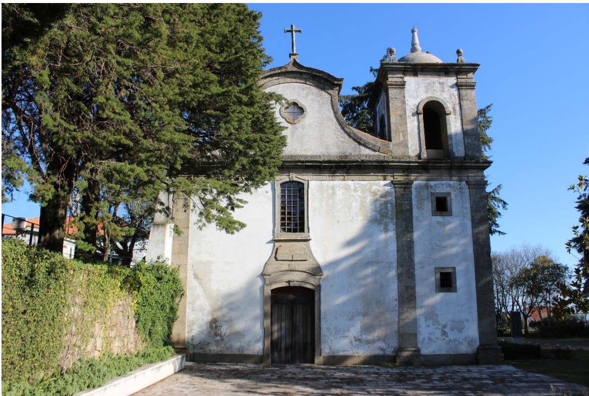
Figura 16 - Fachada oeste da Igreja de Santa Maria do Castelo. (Fotografia do autor, 2020)
