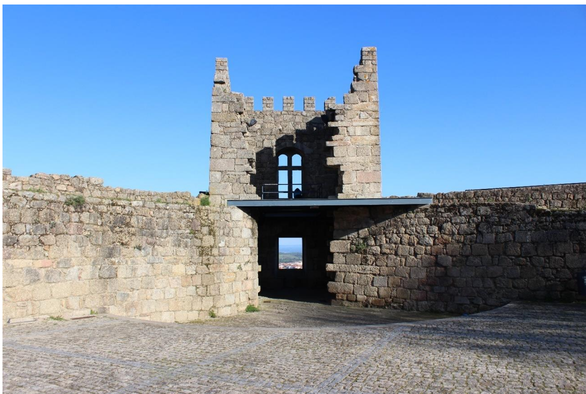
Figura 23 - Torre nordeste na interseção das muralhas norte e este. (Fotografia do autor, 2020)
