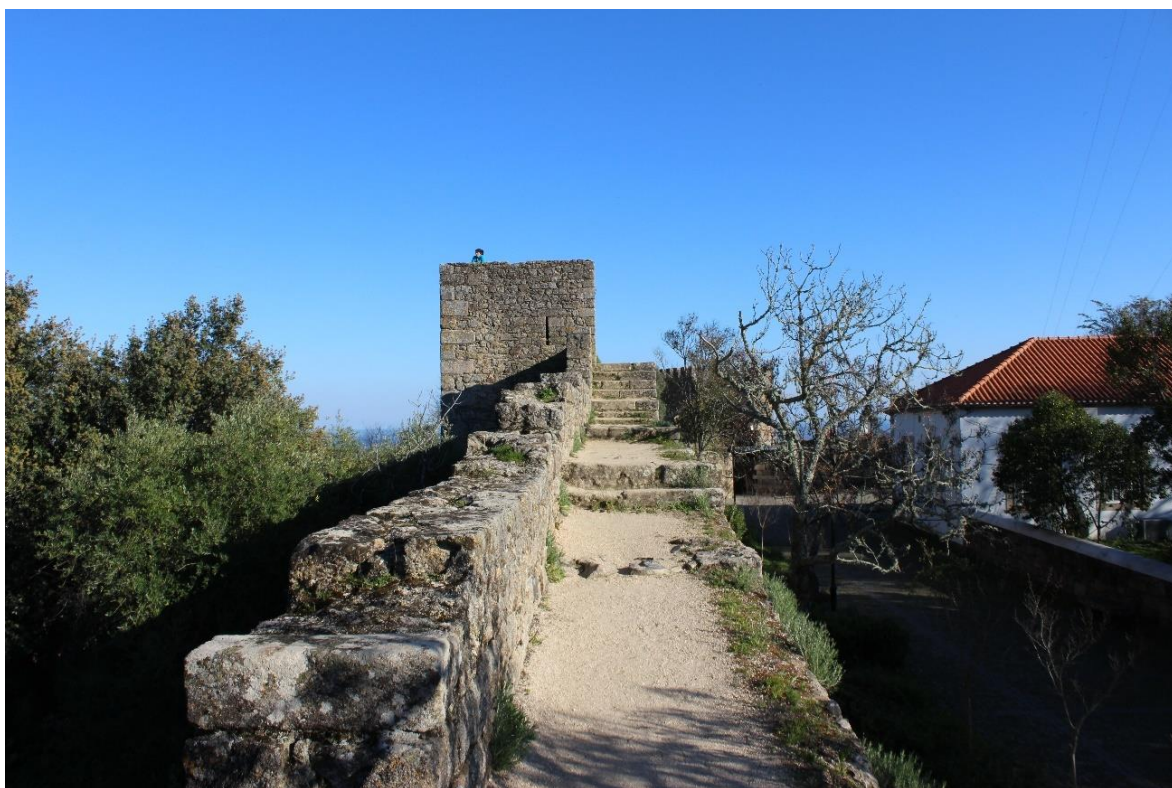
Figura 19 - Muralha e Torre norte. (Fotografia do autor, 2020)
