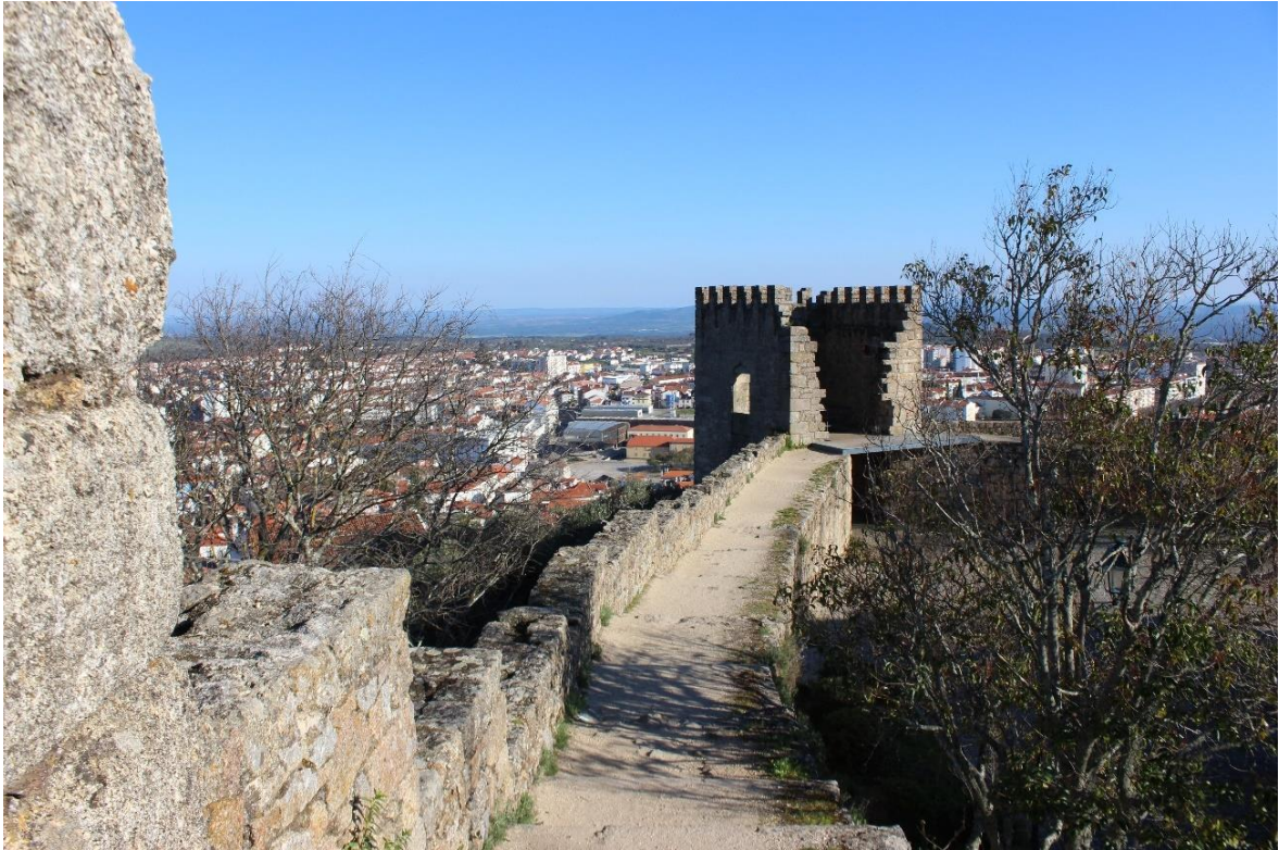
Figura 20 - Muralha norte e Torre nordeste. (Fotografia do autor, 2020)
