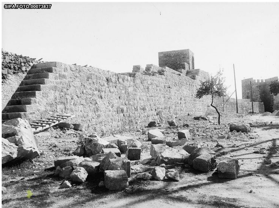
Figura 5 - Obras de recuperação do castelo realizadas no século XX. (SIPA, 2011)
