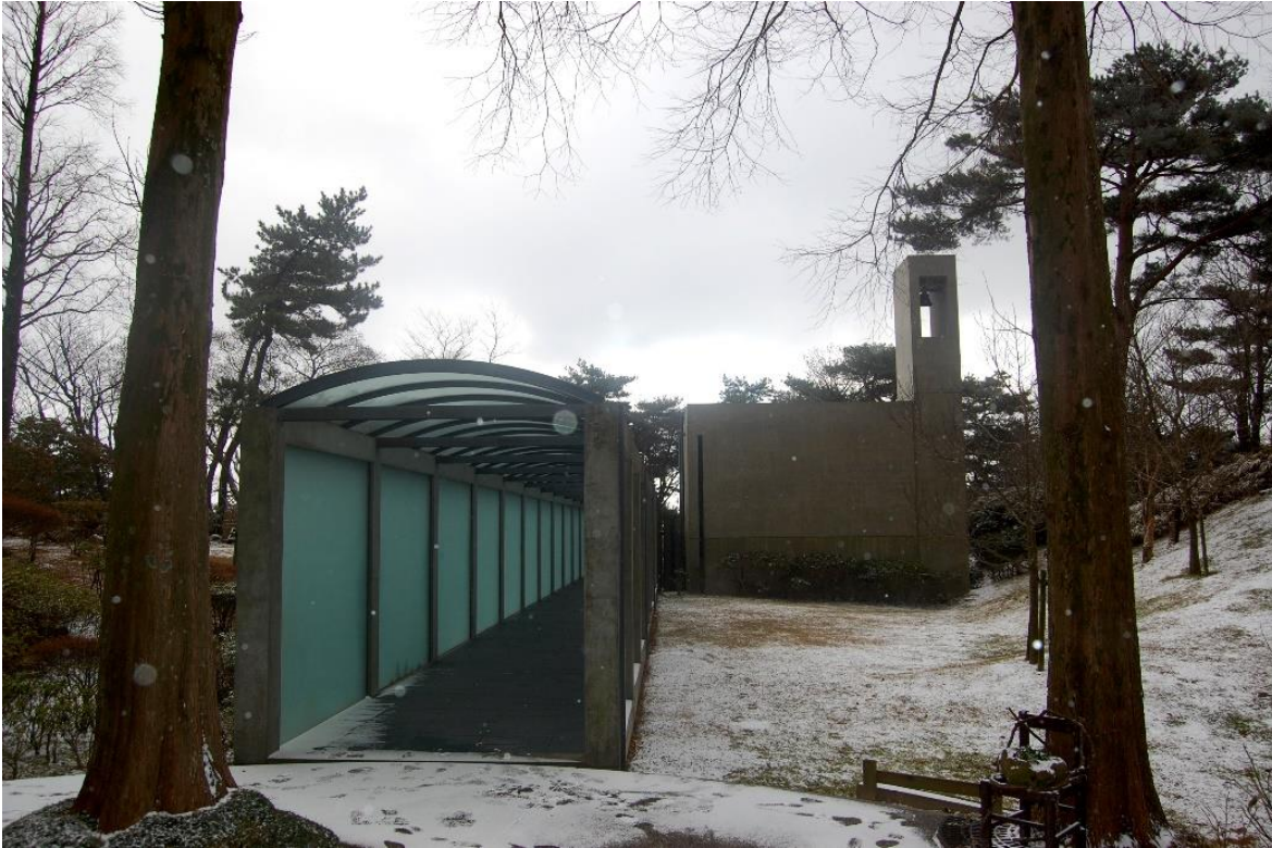
Figura 47 - Capela no Monte Rokko, Japão, realizada por Tadao Ando. (Franca, 2006)
