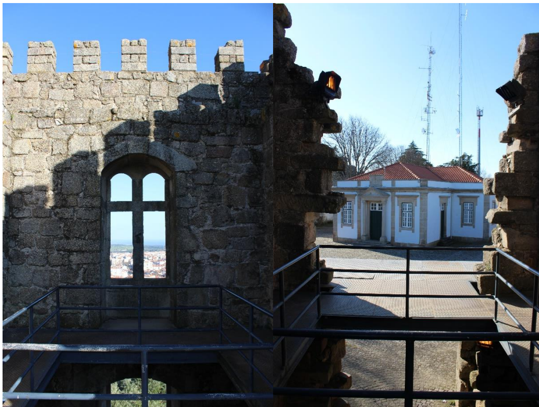
Figura 24 - Primeiro piso da Torre nordeste. Vista interior e vista exterior, respetivamente. (Fotografia do autor, 2020)
