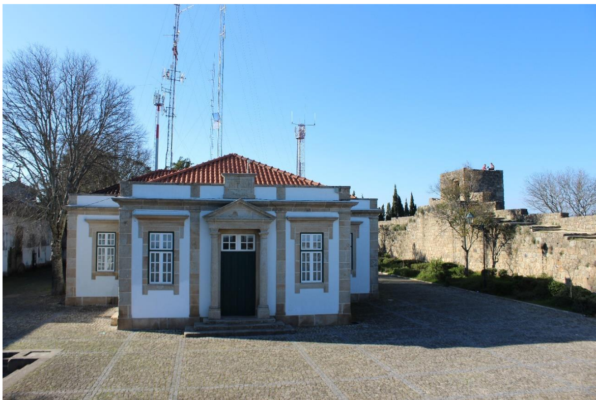
Figura 26 - Antiga escola primária ao centro e muralha norte à direita. (Fotografia do autor, 2020)
