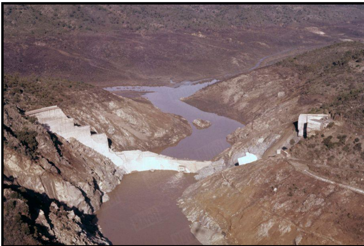
Figura 19: Local da barragem de Malpasset posteriormente ao acidente (Paris Match 2019)
