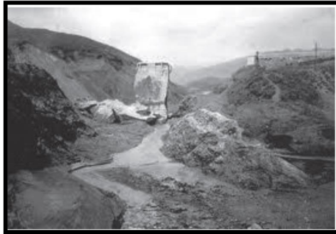
Figura 18: Barragem de St. Francis restos da barragem após o acidente. (Bressan, 2010)
