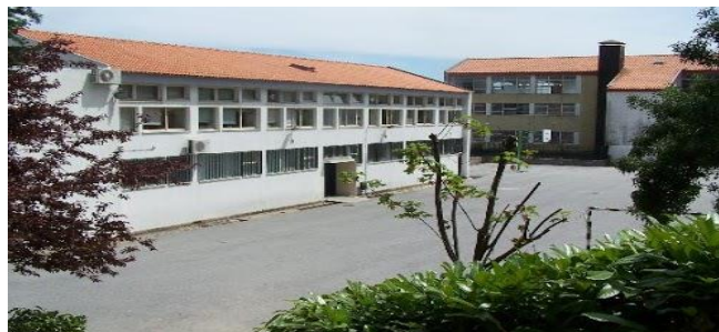
Figura 1 - Escola Secundária Frei Heitor Pinto
