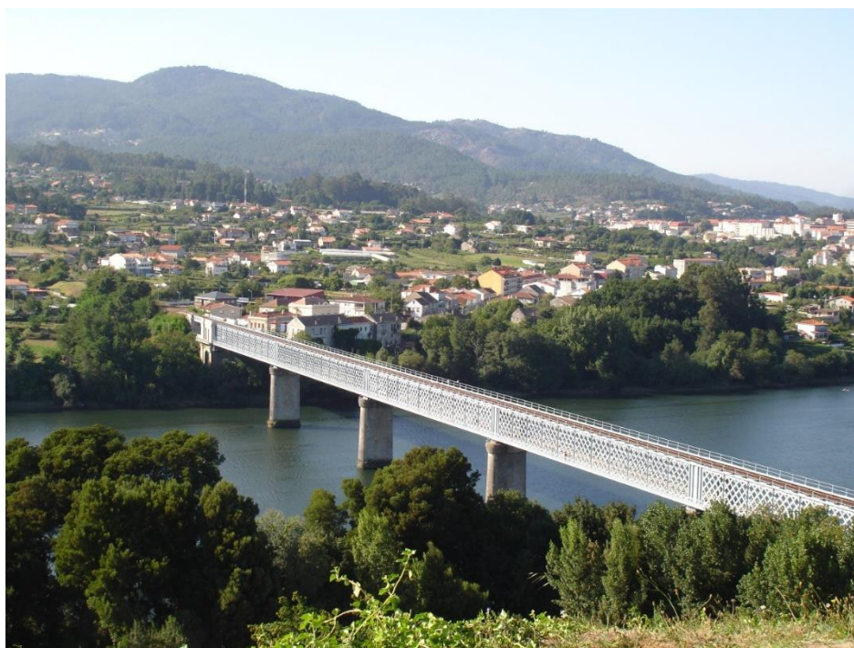
Figura 11 - Ponte Rodo-Feroviária de Valença do Minho.
