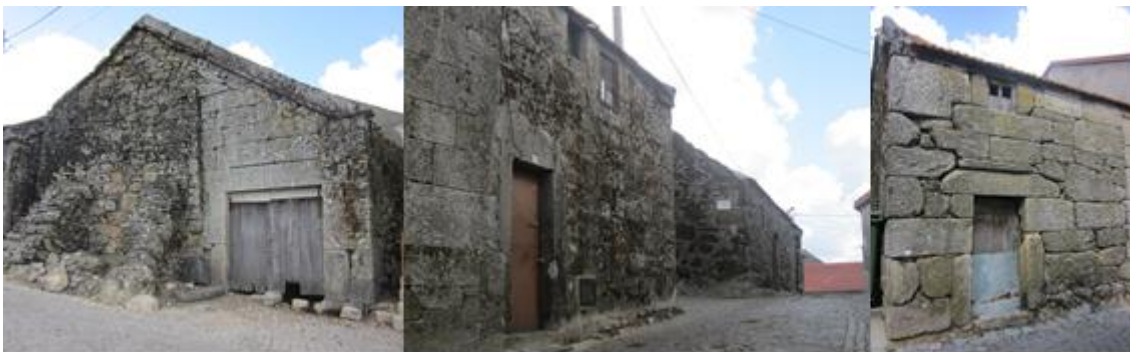
Fotografia 15, 15.1 e 15.2 - Casas em pedra de granito típicas de Alturas do Barroso.
