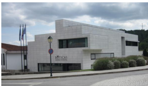
Fotografia 23 - Edifício da Câmara Municipal de Boticas.
