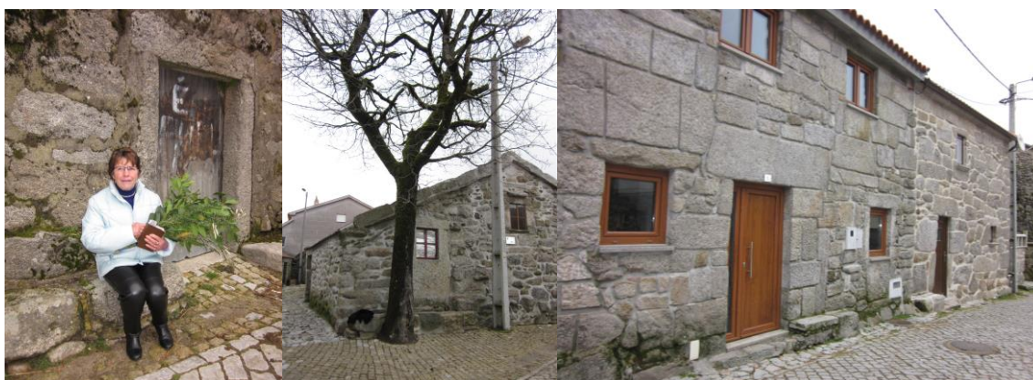
Fotografia 20, 20.1 e 20.2 - O envelhecimento e a recuperação das habitações de Alturas do Barroso.
