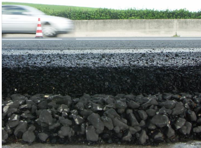
Figura 2.8 - Pavimento com dupla camada (Fonte: Sandberg, 2012)
