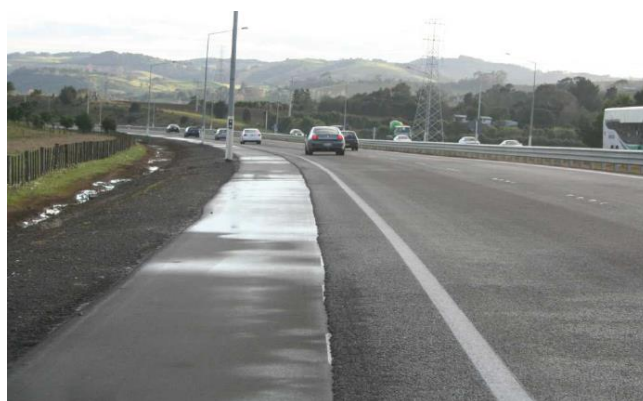
Figura 2.16 - Drenagem livre de camada betuminosa drenante em autoestrada em South Auckland - Nova Zelândia (Fonte: Fletcher e Theron, 2011)
