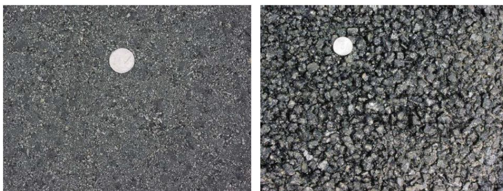
Figura 2.6 - Superfície de camada betuminosa densa e superfície de camada betuminosa drenante (Fonte: Lebens e Troyer, 2012)
