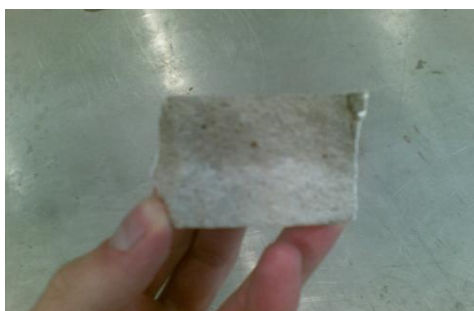
Figura 4.13 - Profundidade da penetração da água
