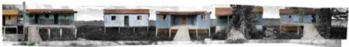
Figura 157 - Patacão de Cima, dique: trecho do perfil fotográfico do lado mais próximo do rio (2012).
