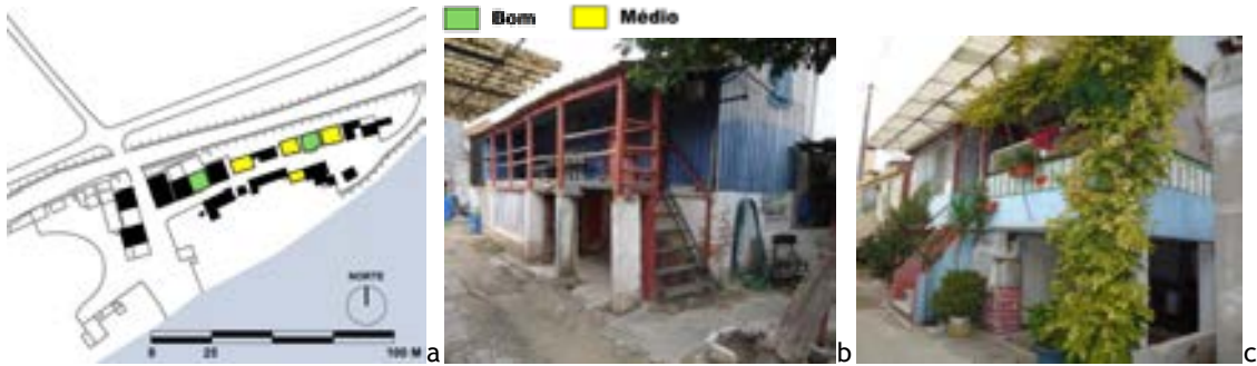
Figura 230 - (a) Lezirão: (b) palafitas em pior (n.º 6) e (c) melhor (n.º 4) estado de conservação.
