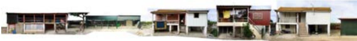
Figura 144 - Lezirão, Rua A: troço do perfil fotográfico do lado norte (2012).
