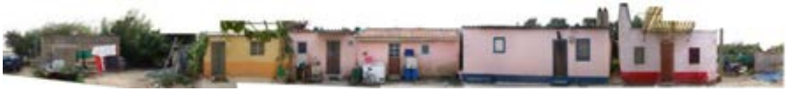
Figura 145 - Lezirão, Rua A: troço do perfil fotográfico do lado sul (2012).
