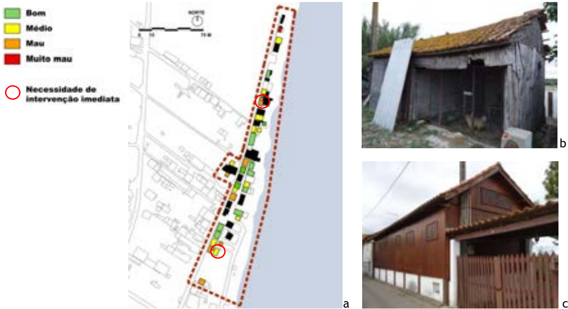
Figura 210 - (a) Caneiras: (b) casa térrea em pior (n.º 26a) e (c) palafita em melhor (n.º 16) estado de conservação.
