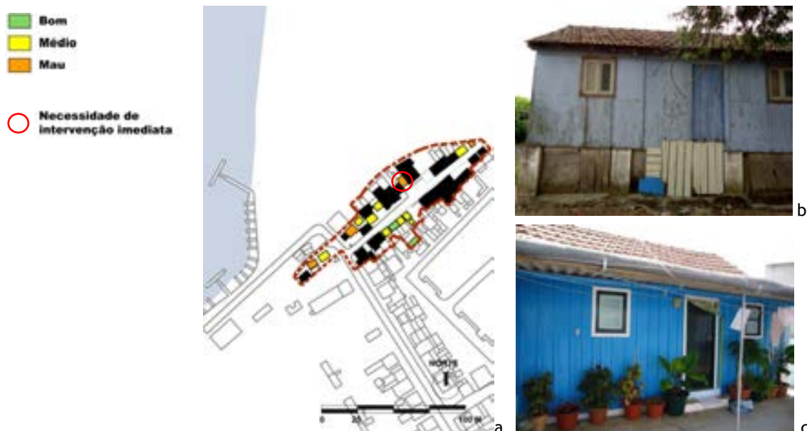
Figura 217 - (a) Escaroupim: (b) palafita em pior (n.º 1) e (c) casa térrea em melhor (n.º 29a) estado de conservação.
