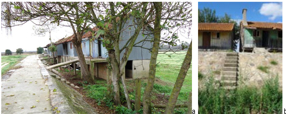
Figura 152 - Patação de Cima, dique: topo e laterais (2012).
