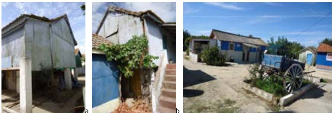
Figura 134 - Palhota: elementos marcantes do núcleo avieiro: a e b. troncos de oliveira na estrutura palafítica de uma casa avieira; c. Largo 1 (2012).
