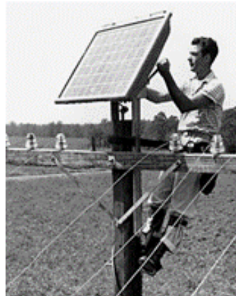
Fig. 7 - A primeira aplicação de uma célula PV de silício foi como fonte de alimentação de uma rede elétrica telefônica local em Americus, na Geórgia, Estados Unidos da América, em 1955 [12].
