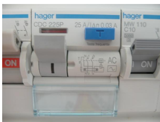
Fig. 45 - Disjuntor diferencial residual de calibre igual ou superior a 30 mA [76].
