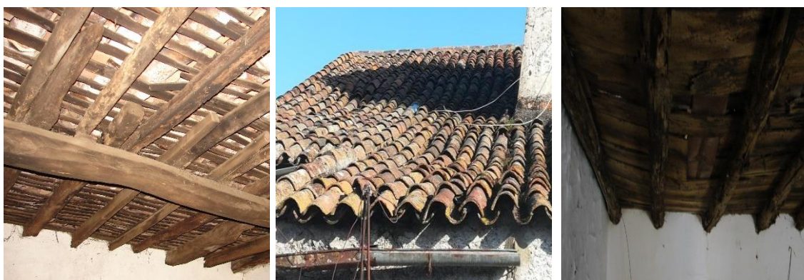
Figura 15 - Exemplos de estruturas e revestimento de coberturas (Rua Dr. Graça e Largo Dr. José de Almeida, Nisa)
