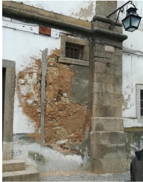
Figura 1 - Exemplo de Parede de Alvenaria de Pedra com Revestimento de Argamassa de Cal e Areia, Rua de Aviz, Évora.
