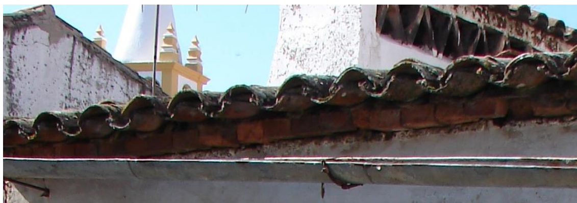
Figura 16 - Exemplo da aplicação de telha de canudo (Rua Capitão Pais de Morais, Nisa)
