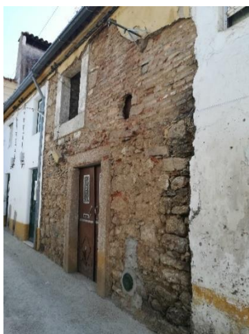
Figura 11 - Exemplo de edifício com alvenaria mista de pedra e adobe (Rua de Angola, Nisa)
