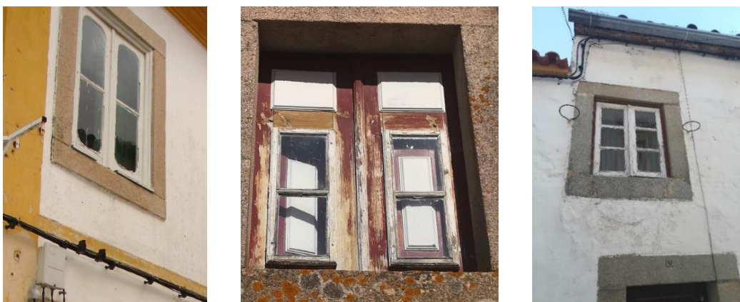
Figura 17 - Exemplos de caixilharias de madeira (Rua Dr. Graça, Nisa)
