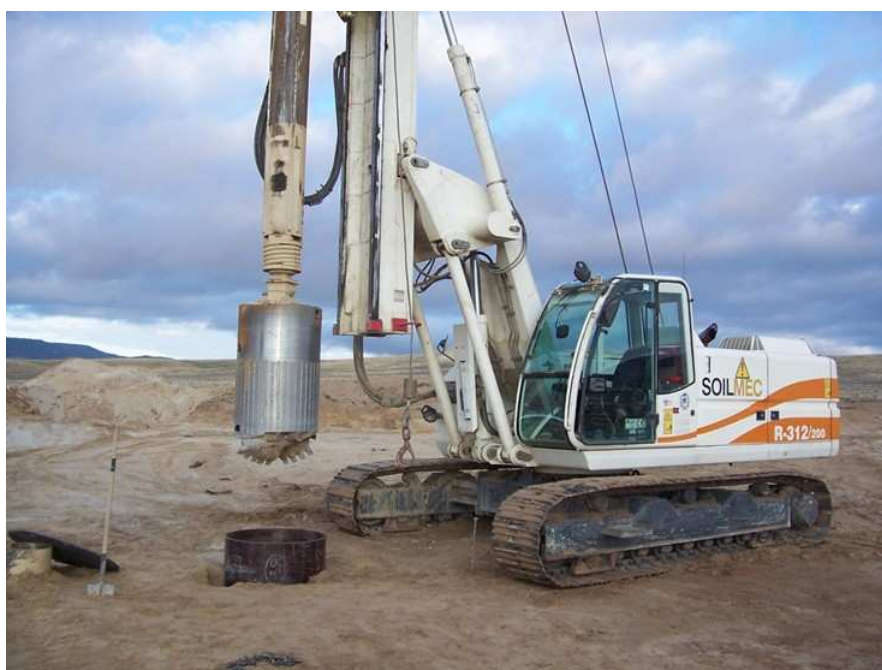
Fig. 1.6 – Exemplo de perfuração Kelly (Soilmec, 2009)
