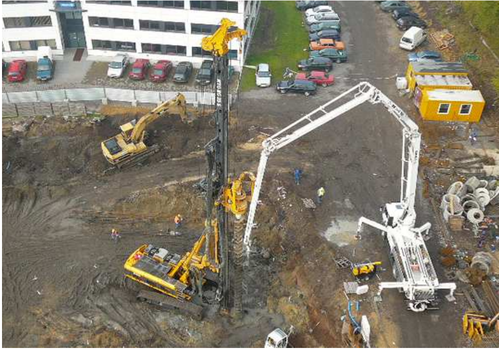
Fig. 1.7 Exemplo de perfuração trado contínuo oco (Soilmec, 2009).
