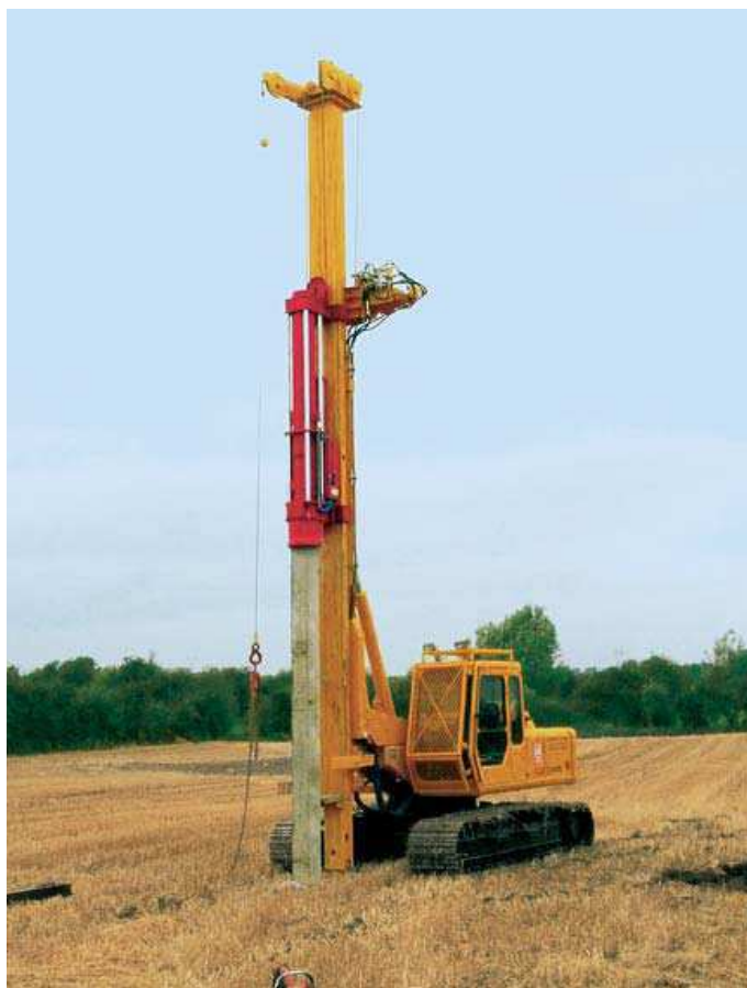
Figura 5.3 – Imagem representativa da maquinaria usada na cravação das estacas nesta obra.
