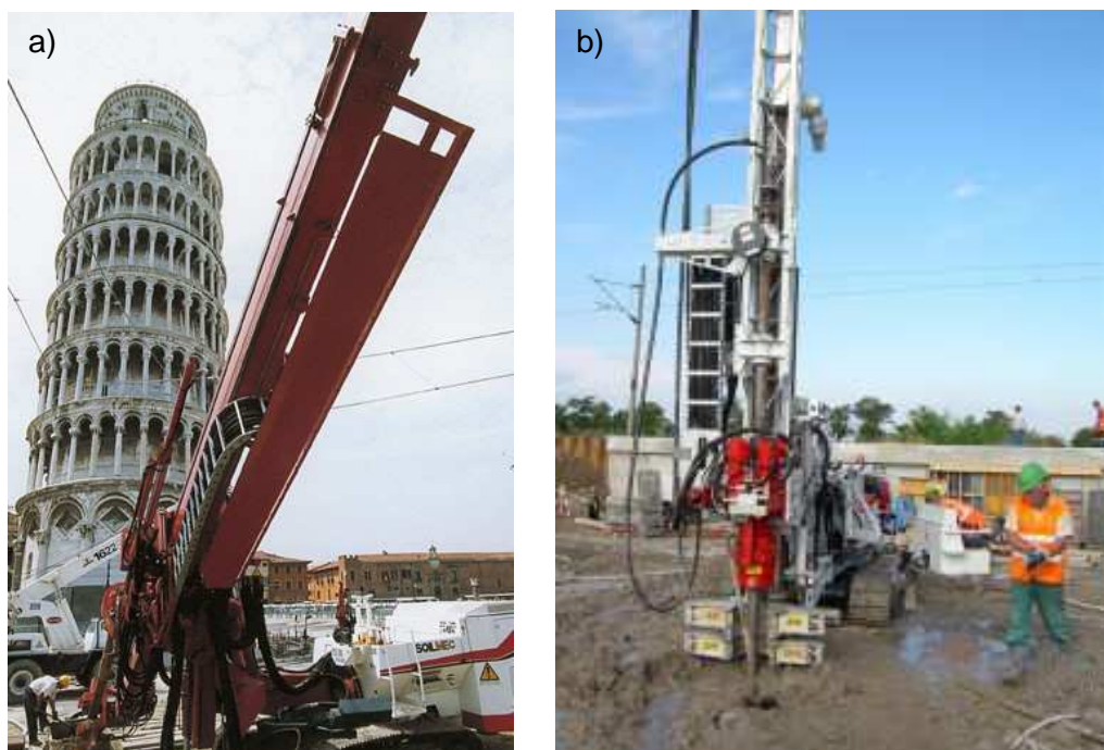
Fig. 1.14 a) e b) – Trabalhos de Jet Grouting (Soilmec, 2009).
