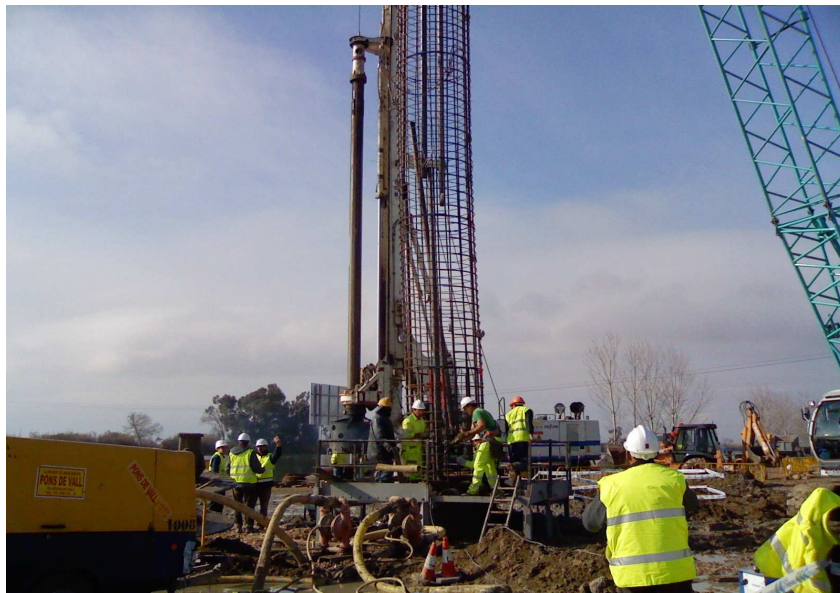
Fig. 1.8 Exemplo da introdução da armadura em estaca de grande diâmetro (1800mm) escavada pelo método Kelly aquando dos trabalhos da ponte sobre o rio Ebro em Deltebre – Espanha (2009).
